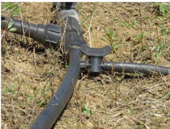
Εικόνες 5.6.2 και 5.6.3. Σύνδεση αγωγών μεταφοράς με αγωγούς εφαρμογής.
