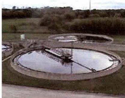
Εικόνα 4.7.1.2.1. Δεξαμενές καθιζήσεως (Ράμμος Ι., 2006)
