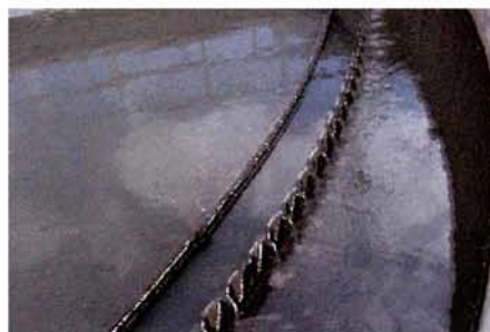
Εικόνα 4.7.1.2.3. Υπερχείλιση του καθαρού υγρού για περαιτέρω επεξεργασία (Ράμμος Ι., 2006).
