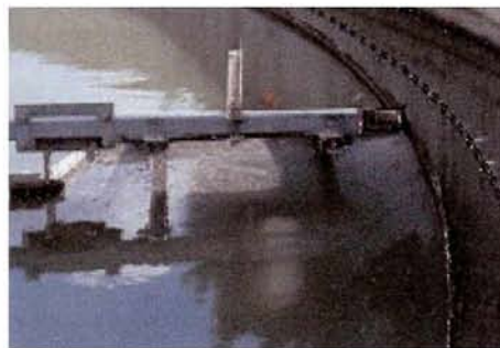
Εικόνα 4.7.1.2.2. Μηχανισμός αφαίρεσης των ουσιών που επιπλέουν (Ράμμος Ι., 2006).
