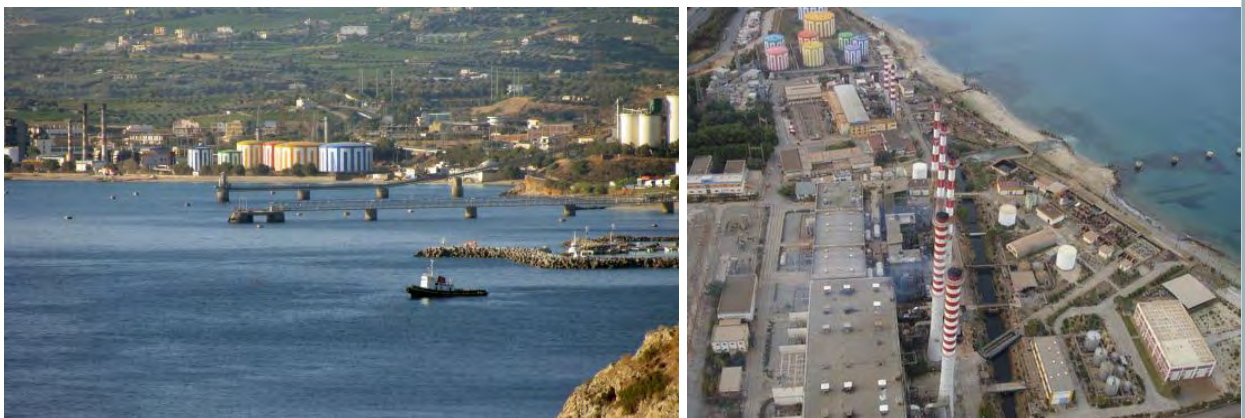
[18] Περιοχή Λινοπεραμάτων – Γαζίου, πλατφόρμες φορτοεκφόρτωσης των πετρελαϊκών εταιρειών και των εταιρειών παραγωγής τσιμέντου και ΑΗΣ της ΔΕΗ
