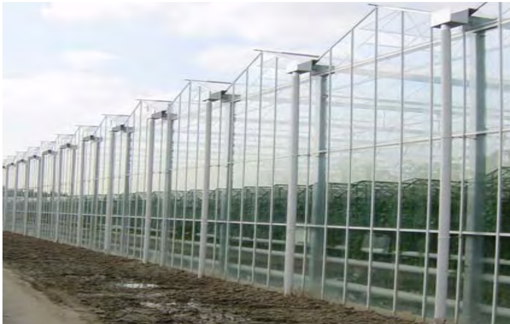
Εικόνα 2.1. Τυποποιημένο Αμφικλινές Πολλαπλό Υαλόφρακτο Μεταλλικό Θερμοκήπιο
