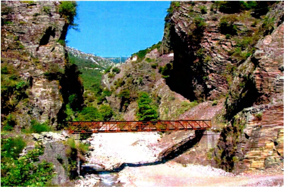
Εικόνα 4.2 Η παλαιά γέφυρα στην εν λόγω τοποθεσία
