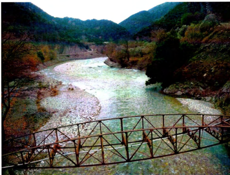
Εικόνα 4.1 Η υπάρχουσα σιδερένια γέφυρα.
