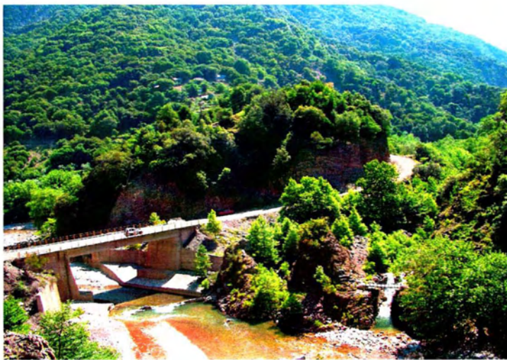
Εικόνα 4.3 Η υπάρχουσα γέφυρα στον Καρβασαρά Αγράφων
