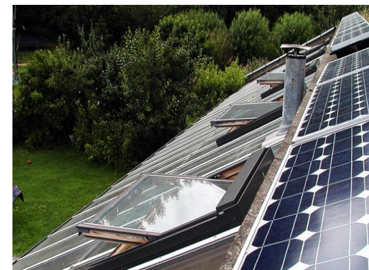
εικ.7.12: Φεγγίτες και γυάλινες σκεπές για το φυσικό φωτισμό του κτιρίου (πηγή: http://www.zeroenergybuildings.org/2012/10/hockerton-housing-project.html )
