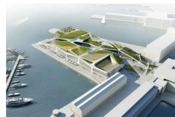
εικ.3.30: Άποψη των έργων παρέμβασης στο παραλιακό μέτωπο (πηγή: http://www.bluffton.edu/~sullivanm/italy/genoa/bigopiano.html )
