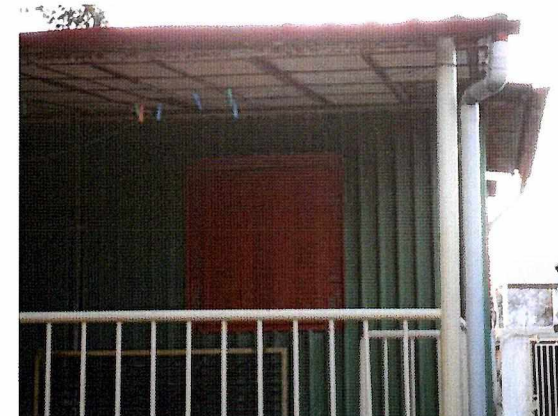
Εικόνα 88 Χρήση Λαμαρίνας για Τοιχοποιία σε Αυθαίρετο Οίκημα –Εφήμερη Υλικότητα
