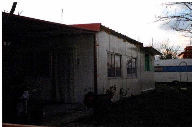
Εικόνα 83,84 Αυθαίρετη Κατασκευή με Μεταλλικά Panels Πλήρωσης
