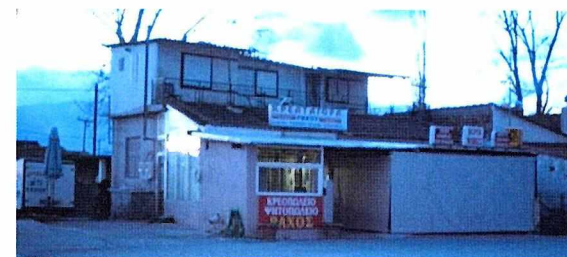
Εικόνα 60 Αυθαίρετο-Επαγγελματικός Χώρος με Οριζόντια και Κατακόρυφη Επέκταση
