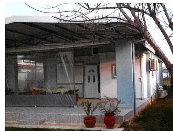
Εικόνα 68 Αυθαίρετη Κατασκευή _ «Κινούμενο» - Μισοτελειωμένο Κτίσμα
