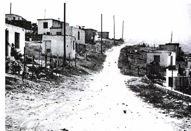
Εικόνα 22 Τυπικός δρόμος αυθαίρετου οικισμού_ Έλλειψη υποδομών
