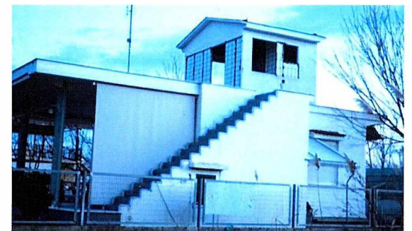
Εικόνα 71 Αυθαιρέτη Καθ' Ύψος Κατασκευή _ «Κινούμενο» - Μισοτελειωμένο Κτίσμα
