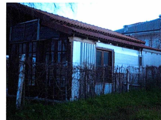
Εικόνα 86,87 Αυθαίρετες Κατασκευές με Μεταβολισμένα -Ως Προς τη Χρήση τους- Υλικά Δόμησης και Πλήρωσης
