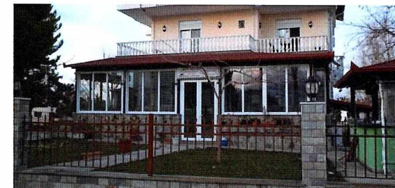
Εικόνα 66 Ολοκληρωμένη Επέκταση της Αυθαίρετης Κατασκευής
