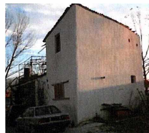
Πίσω όψη αρχικού κτίσματος
