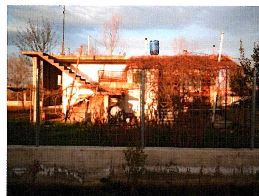
Πίσω όψη σπιτιού με αναμονές για πάνω-σήκωμα
