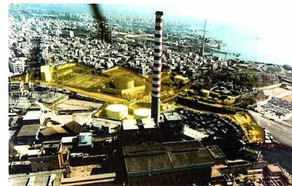
7. Αυθαιρεσίες σε Βιομηχανική περιοχή
