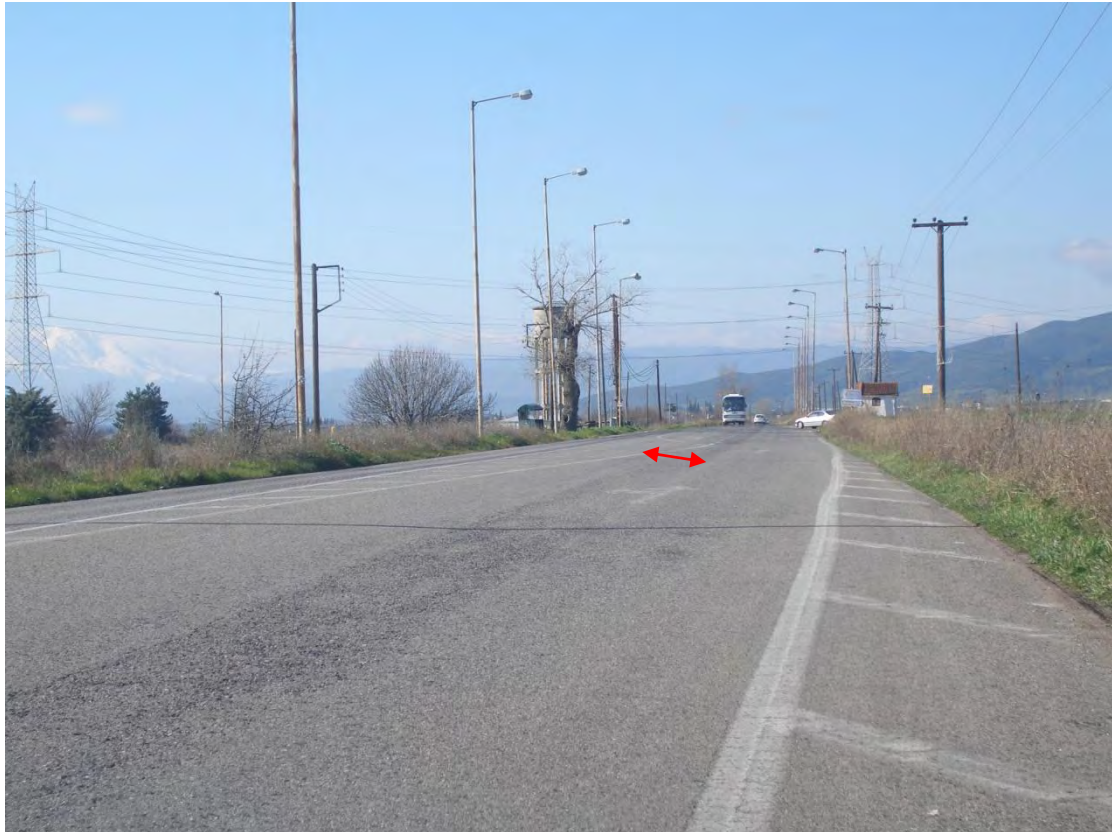
Εικόνα 5.4: Ισόπεδος κόμβος Χ.Θ. 3+460, με διαμόρφωση αριστερόστροφων κινήσεων
