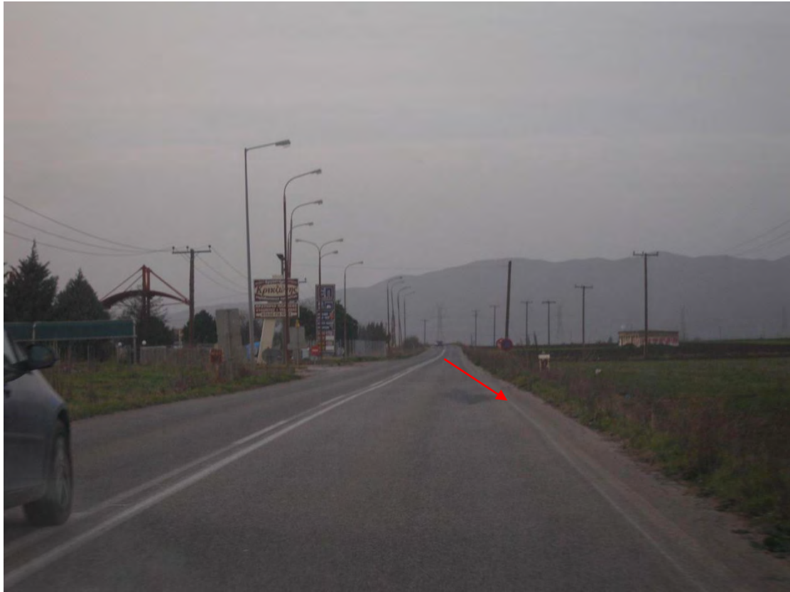
Εικόνα 5.5: Χαρακτηριστική ευθυγραμμία με μικρό έρεισμα και φθαρμένη λωρίδα εσωτερικής καθοδήγησης. Συναντάται κατά κόρον στο εξεταζόμενο δίκτυο.
