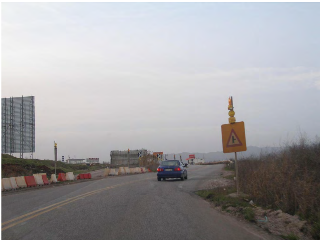
Εικόνα 5.3: Ζώνη έργων, η οποία διατηρείται επί μακρόν, λόγω εγκατάλειψης των εργασιών
