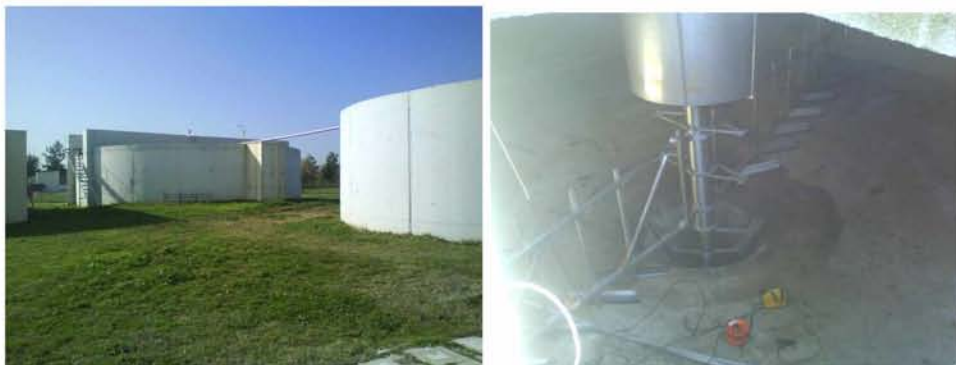
Εικόνα 4.16 – 4.17: Εξωτερικό και εσωτερικό παχυντή ιλύος.
