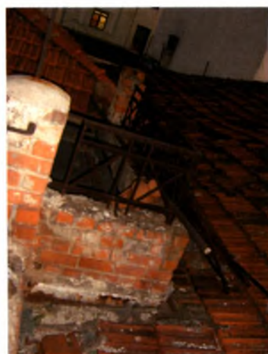
ΟΙ ΘΕΣΕΙΣ ΣΥΝΔΕΣΗΣ ΤΩΝ ΜΕΤΑΛΛΙΚΩΝ ΔΟΚΩΝ ΜΕ ΤΗΝ ΛΙΘΟΔΟΜΗ
