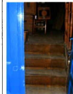
Η ΕΙΣΟΔΟΣ ΤΟΥ ΗΜΙΩΡΟΦΟΥ ΜΕΣΑ ΑΠΟ ΤΟ ΚΤΙΡΙΟ 3
