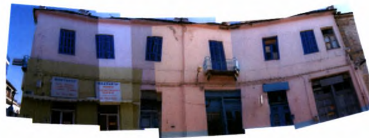
ΤΟ ΚΤΙΡΙΟ 3 ΑΠΟ ΤΗΝ ΟΔΟ ΣΥΝΤΑΓΜΑΤΟΣ
