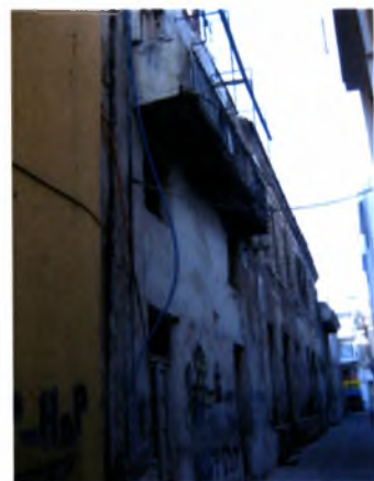
ΤΟ ΚΤΙΡΙΟ 2 ΑΠΟ ΤΗΝ ΟΔΟ ΣΚΙΑΦΟΥ
