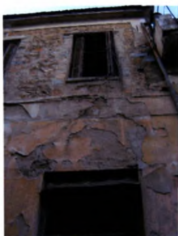
ΕΞΩΤΕΡΙΚΗ ΕΠΙΦΑΝΕΙΑ ΜΕ ΑΠΟΚΟΛΛΗΣΗ ΣΟΒΑΔΩΝ
