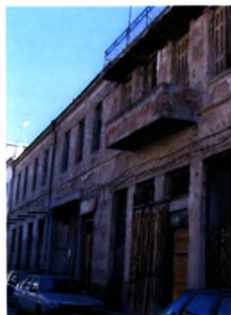
ΤΟ ΚΤΙΡΙΟ 2 ΑΠΟ ΤΗΝ ΟΔΟ ΣΥΝΤΑΓΜΑΤΟΣ
