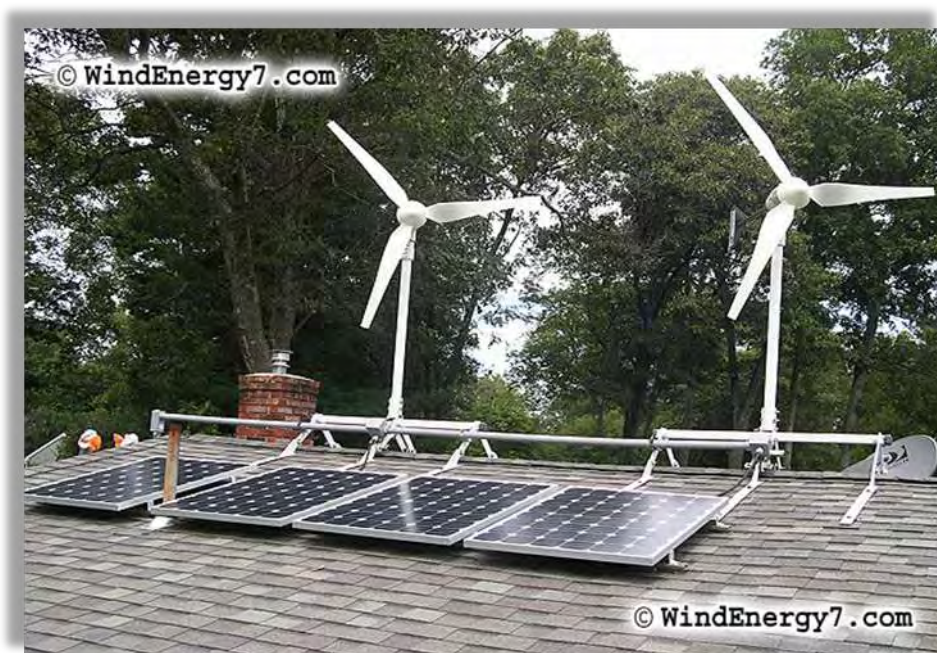
Εικόνα 15 : συνδιασμός δύο μορφών ΑΠΕ σε κτίριο κατοικίας στη Μασσαχουσέτη
