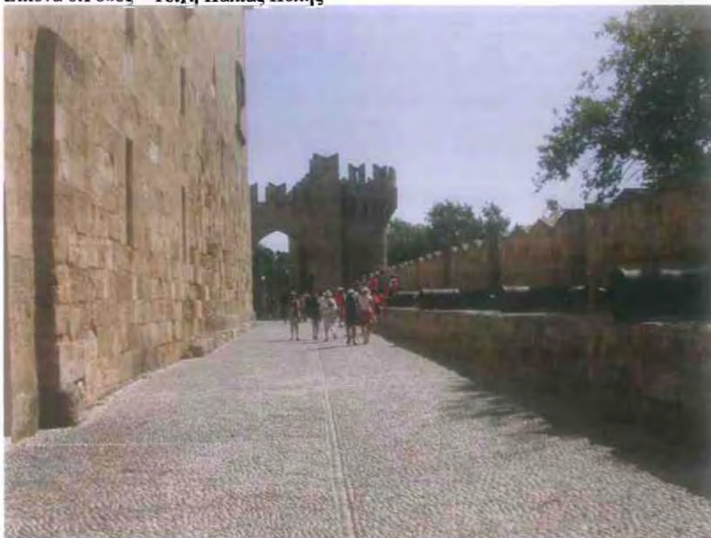
Εικόνα 6: Ρόδος – Τείχη Παλιάς Πόλης
