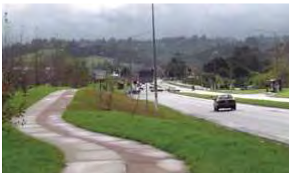
Εικόνα 3: Παράλληλος προς τον δρόμο ποδηλατόδρομος
