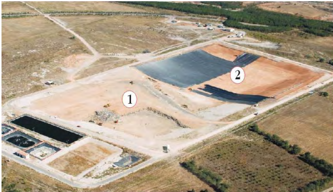
Εικόνα 3: Διακρίνεται το πρώτο κύτταρο (1) και το δεύτερο κύτταρο (2) του ΧΥΤΑ δυτικής Μακεδονίας, Αύγουστος 2006, (ΠΗΓΗ: http://www.diadyma.gr )
