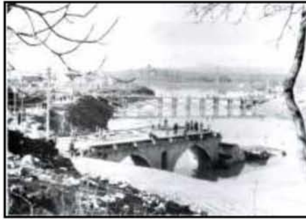
Εικόνα 18: Καταστροφή γέφυρας Πηνειού ( www.larissa-dimos.gr )
