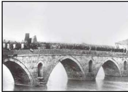
Εικόνα 17: Η παλιά γέφυρα του Πηνειού (www.vres.gr)
