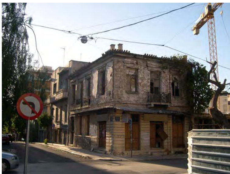
Εικόνα 4.2.1.: Εγκαταλελειμμένο συνεργείο μηχανών.
