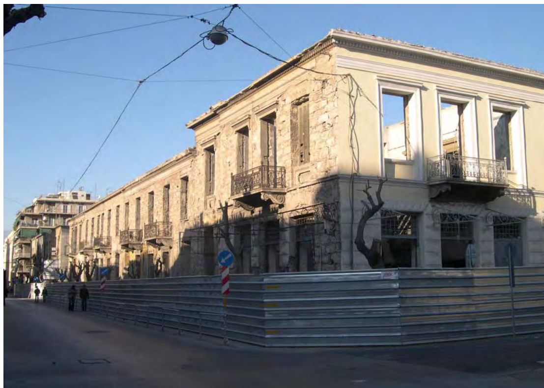
Εικόνα 3.2.3.: Το παλιό μεταξουργείο στη σημερινή του κατάσταση.
