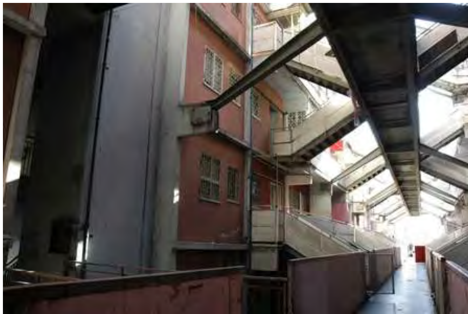
Φωτογραφία 21: Εσωτερική είσοδος των διαμερισμάτων
