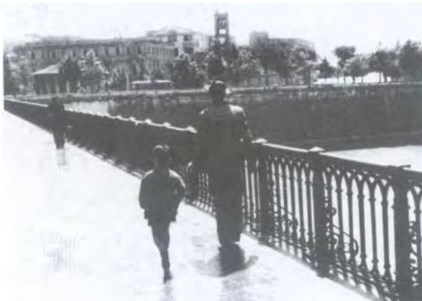
Φωτογραφία 32: Η γέφυρα Ponte Palatino
