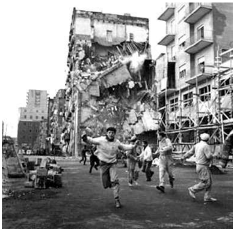
Φωτογραφία 5. Κατεδάφιση ενός ερειπωμένου κτιρίου (Πηγή: http://www.architettura.supereva.com/movies/20041130.htm )
