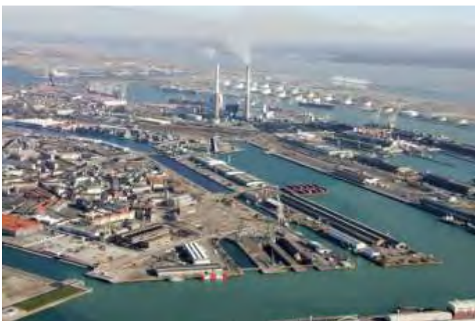
Εικόνα 23:Οι εγκαταστάσεις του λιμανιού της Χάβρης (Πηγή: ESPO)
