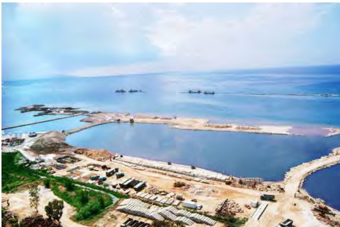
Εικόνα 25: Εργασίες κατασκευής του Νέου Λιμένα Πατρών (Πηγή:Patrasport.gr)
