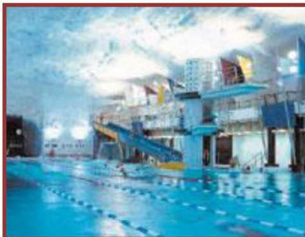
Εικόνα 28: Υπόγεια πισίνα “Itäkeskus” στη Φινλανδία (Πηγή: Samwel, 2003)
