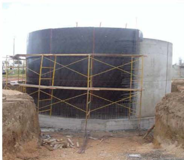
Εικόνα 4.28: Ομογενοποιητής κατά την διάρκεια κατασκευής του.
