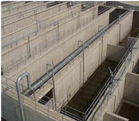
Εικόνα 4.19 – 4.20: Αερισμός και διαχυτήρες κατά την διάρκεια μη λειτουργίας της μονάδας στην ΕΕΛ Λάρισας.
