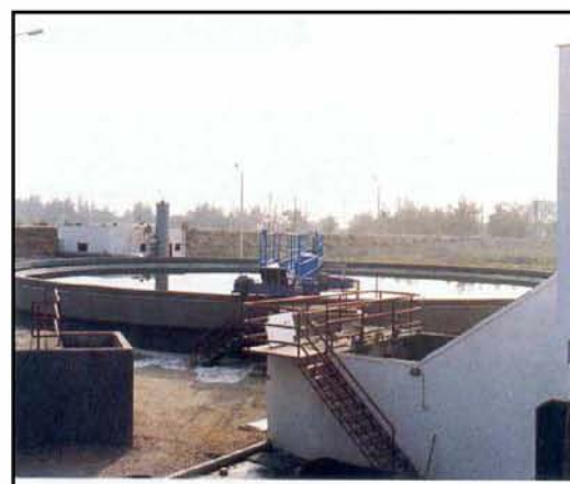
Εικόνα 4.15 – 4.16: Δεξαμενές πρωτοβάθμιας καθίζησης.
