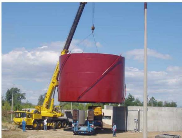
Εικόνα 4.34: Αεροφυλάκιο βιοαερίου κατά την διάρκεια της τοποθέτησής του.
