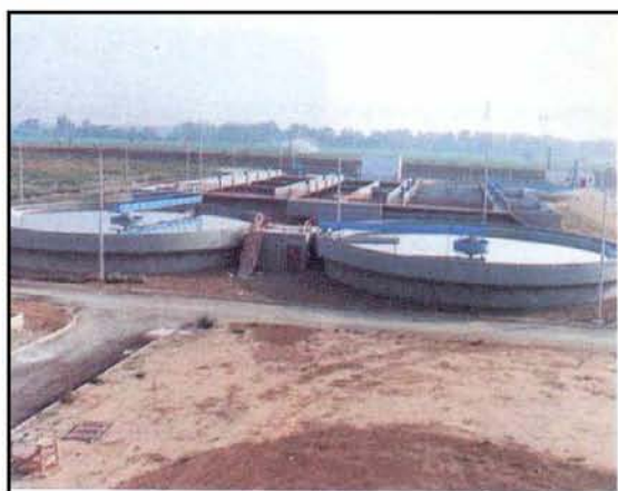
Εικόνα 4.15 – 4.16: Δεξαμενές πρωτοβάθμιας καθίζησης.
