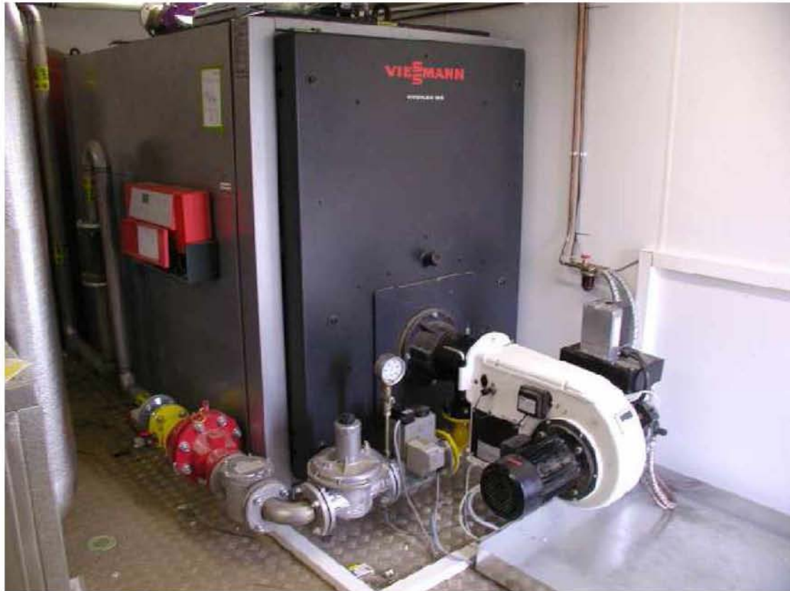
Εικόνα 3.1: Καυστήρας βιοαερίου για παραγωγή θερμότητας (AGRINZ GmbH, 2008)
