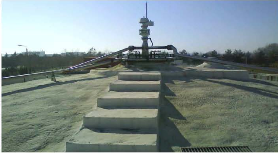
Εικόνα 4.30: Ασφαλιστικές δικλίδες υπερπίεσης οροφής χωνευτή.
