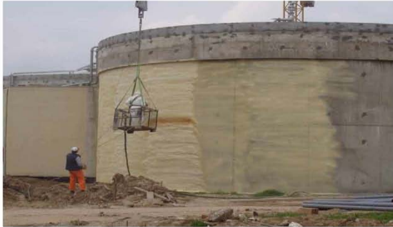
Εικόνα 4.29: Διαδικασία εξωτερικής μόνωσης χωνευτή.
