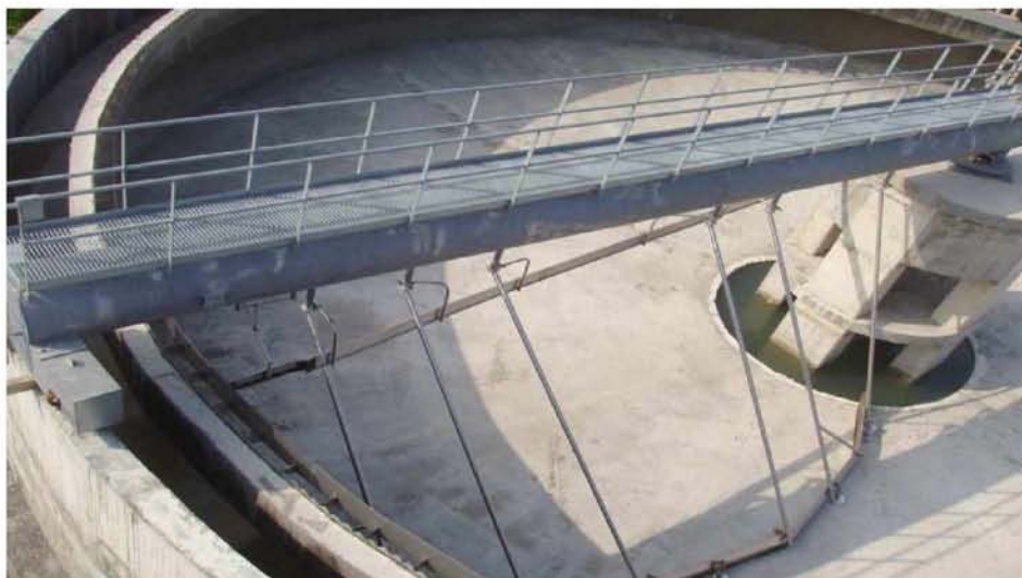
Εικόνα 4.14 Δεξαμενή πρωτοβάθμιας καθίζησης.
