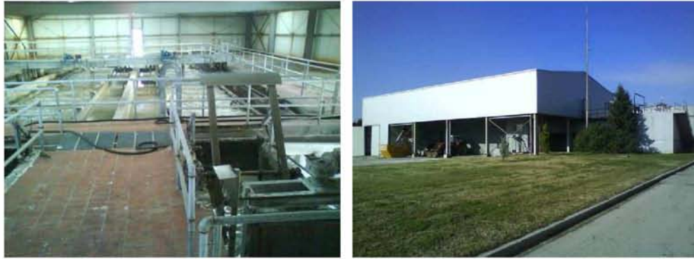
Εικόνα 4.11 – 4.12: Εσωτερικό και εξωτερικό μονάδας εξάμμωσης στην ΕΕΛ Λάρισα.
