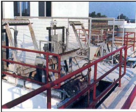
Εικόνα 4.9 - 4.10: Αντλίες αέρος για την απομάκρυνση της άμμου.
