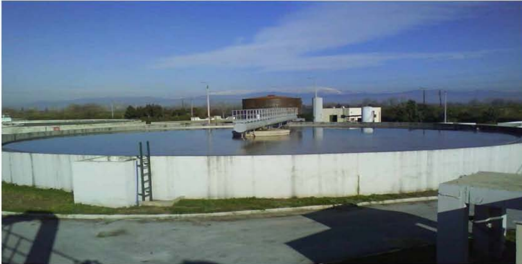
Εικόνα 4.21: Δεξαμενή Δευτεροβάθμιας καθίζησης.
