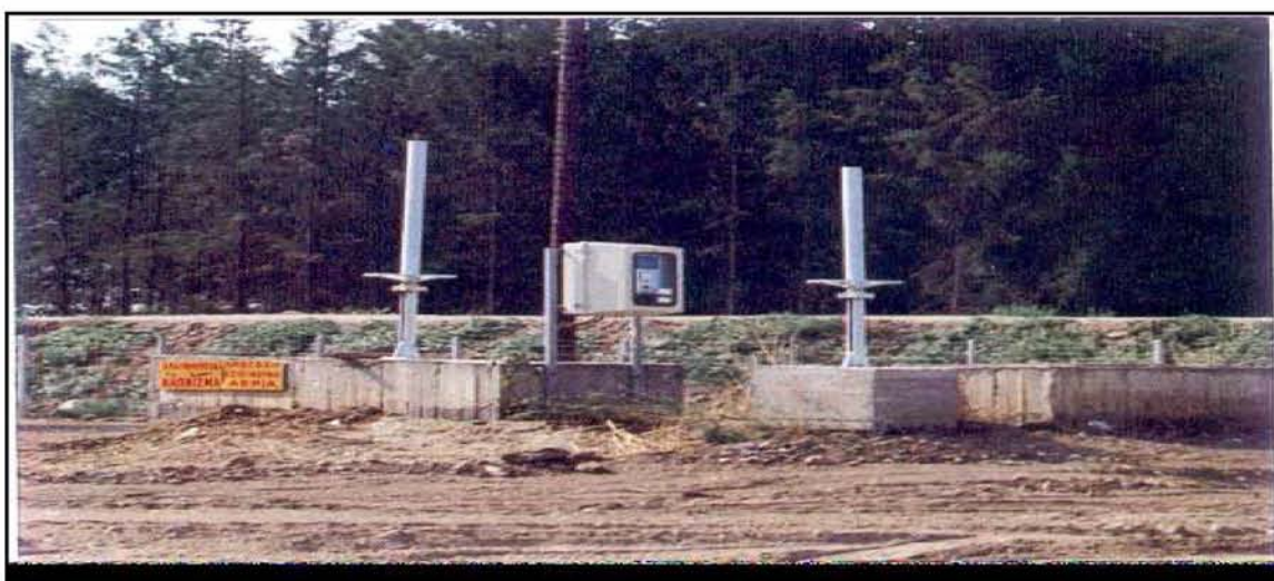
Εικόνα 4.2: Φρεάτιο άφιξης υπάρχει και συσκευή μέτρησης δια υπερήχων της παροχής
