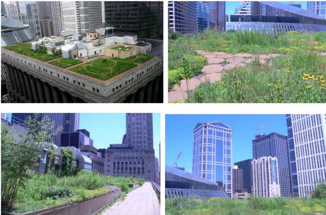
Εικόνα 14: Φυτεμένη στέγη του κτιρίου Δημαρχείου στο Σικάγο
