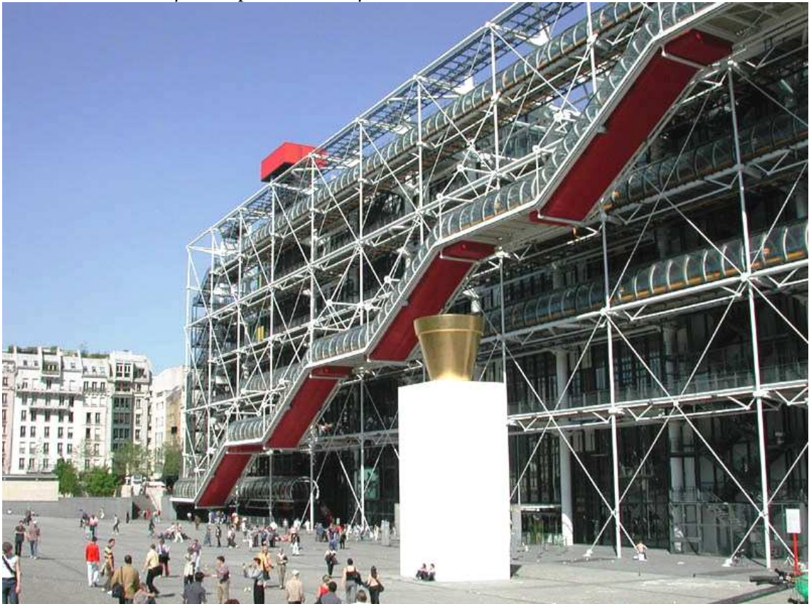
Εικόνα 12: Το Κέντρο Pompidou στο Παρίσι
