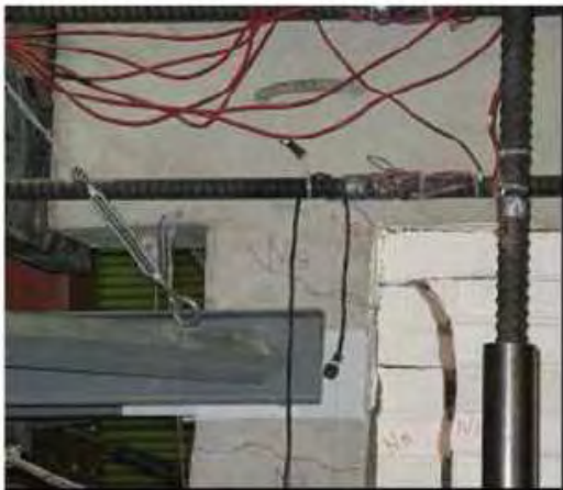
πάνω τμήμα φορτιζόμενου υποστυλώματος
