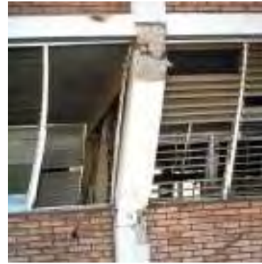
Φωτ. 1.2: Αστοχία κοντών υποστυλωμάτων.
