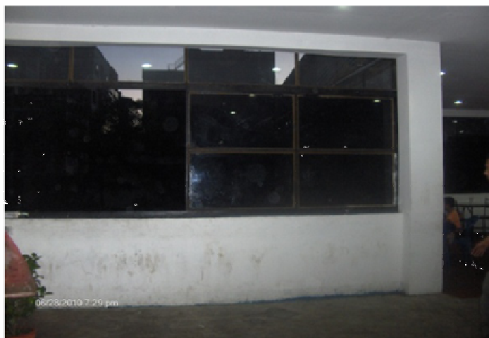
Φωτ. 2.1: Κατασκευή με μερική τοιχοπλήρωση.
