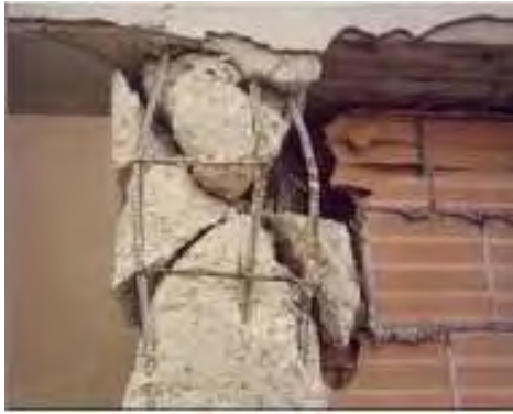
Φωτ. 1.2: Αστοχία κοντών υποστυλωμάτων.
