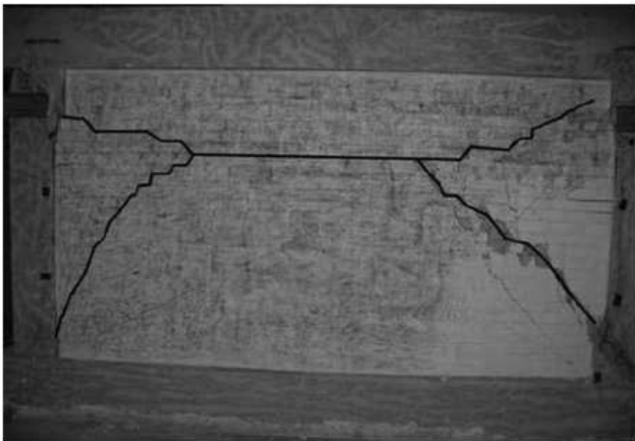
Σχ.3.51 Ρωγμές τοιχοπλήρωσης δοκιμίου S μετά το πέρας του πειράματος.
