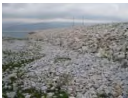
Επίστρωση με ασβεστολιθικής προέλευσης υλικό
