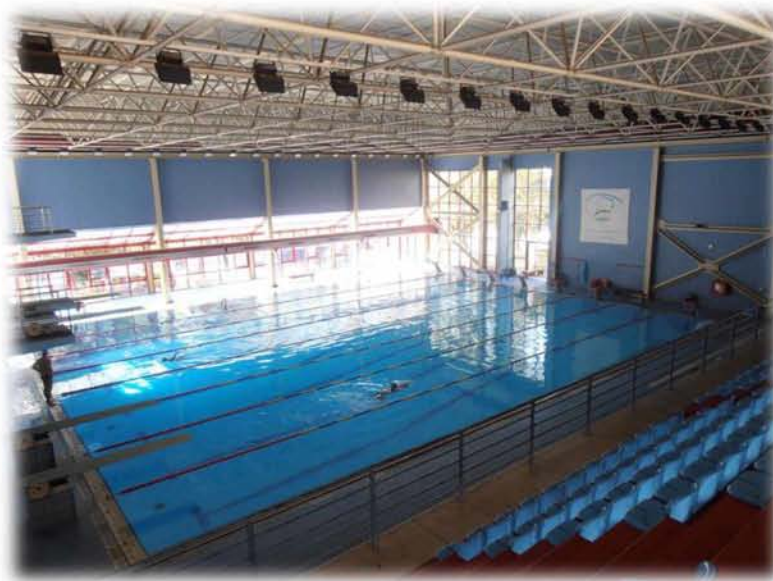
Εικόνα 2.5 Εσωτερική πισίνα 8 διαδρομών.
