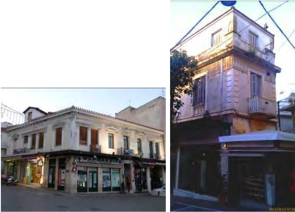
Εικόνα 46. Φωτογραφικό Υλικό της Πλατείας Πάρκου (Δήμου Λαμιέων) και της Πεζοδρομημένης Οδού Ρήγα Φεραίου. Πηγή: Ιδία Επεξεργασία
