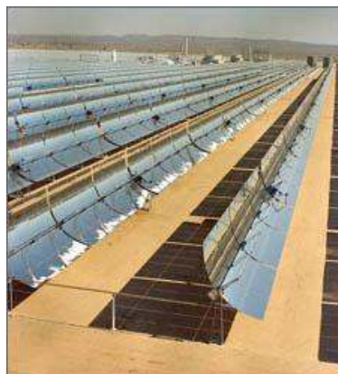
Εικόνα 3.5 Συλλέκτες Παραβολικού Κυλίνδρου (Parabolic Trough Collector)
