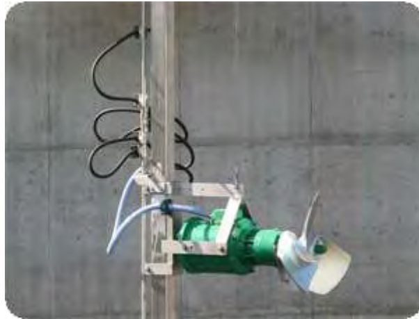
Εικόνα 45: Υποβρύχιος αναδευτήρας. (Πηγή:
