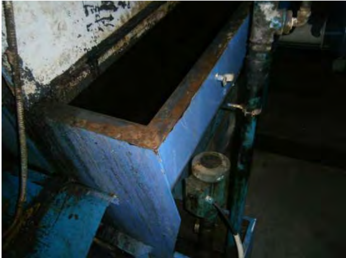
Εικόνα 20: Αντλία λίπους και δεξαμενή διαχωρισμού στερεών – υγρών.
