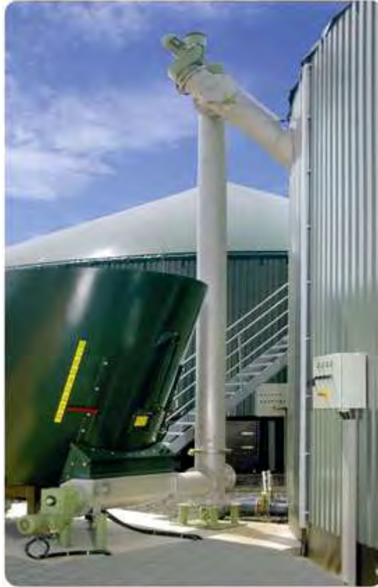
Εικόνα 42: Βιομάζα τροφοδοτείται στο σύστημα μέσω κοχλιομεταφορέα. (Πηγή: http://envima.gr/el/biogas_plants/fotografies_stoixeiwn_egkatakstasis_bioaeriou )
