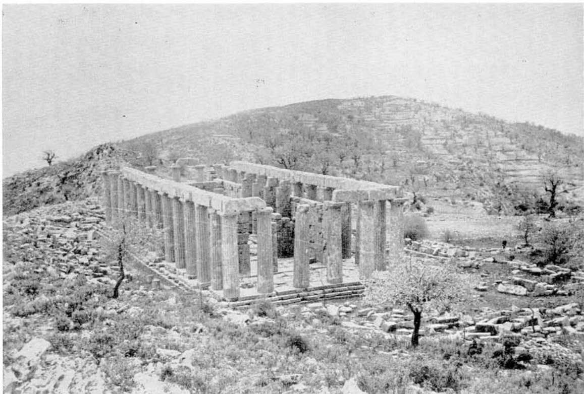
Ἡλεία. Ναὸς Ἐπικούριου Ἀπόλλωνος Βασσῶν : α. Τὸ ἐτοιμόρροπον ἐπιστύλιον παρὰ τὴν ΒΔ. γωνίαν τῆς βορείας πλευρᾶς τοῦ ναοῦ ( κάτω ὄψεις ) πρὸ τῆς ἀποκαταστάσεως αὐτοῦ, β. Λεπτομέρεια τοῦ αὐτοῦ ἐπιστυλίου, γ. Βορεία πλευρὰ τοῦ ναοῦ. Διακρίνεται τὸ παρὰ τὴν ΒΔ. γωνίαν τοῦ ναοῦ ἐπιστύλιον μετὰ τὴν ἀποκατάστασιν αὐτοῦ
