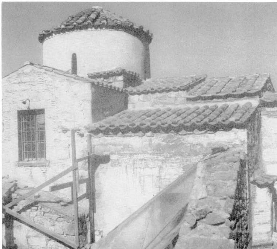
Βοιωτία: α. Χωρίον Ὑψηλάντη. Ναός Ἁγίου Νικολάου, β. Ἀκραίφνιον. Αἱ στέγαι τῶν ἀνατολικῶν χώρων τοῦ ναοῦ τοῦ Ἁγίου Γεωργίου μετὰ τὰς ἐργασίας
