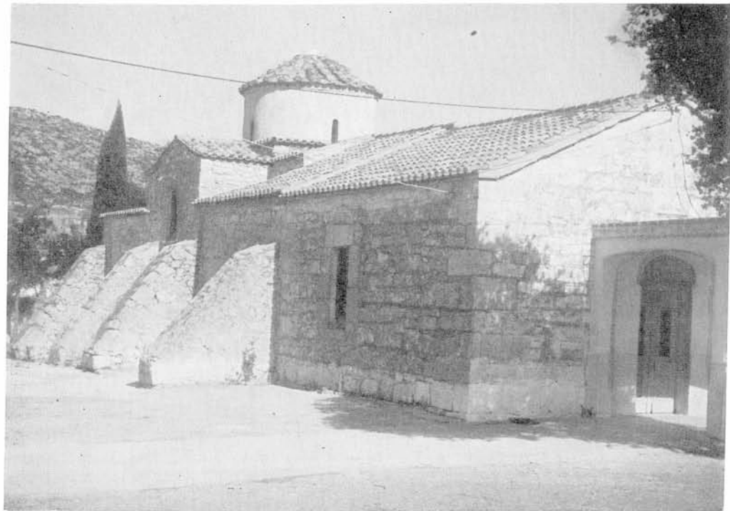
Ἀκραίφνιον. Ναός Ἁγ. Γεωργίου: α. Ὁ τροῦλλος καὶ αἱ κεραῖαι κατὰ τὰς ἐργασίας, β. Ὁ ναός μετὰ τὰς ἐργασίας
