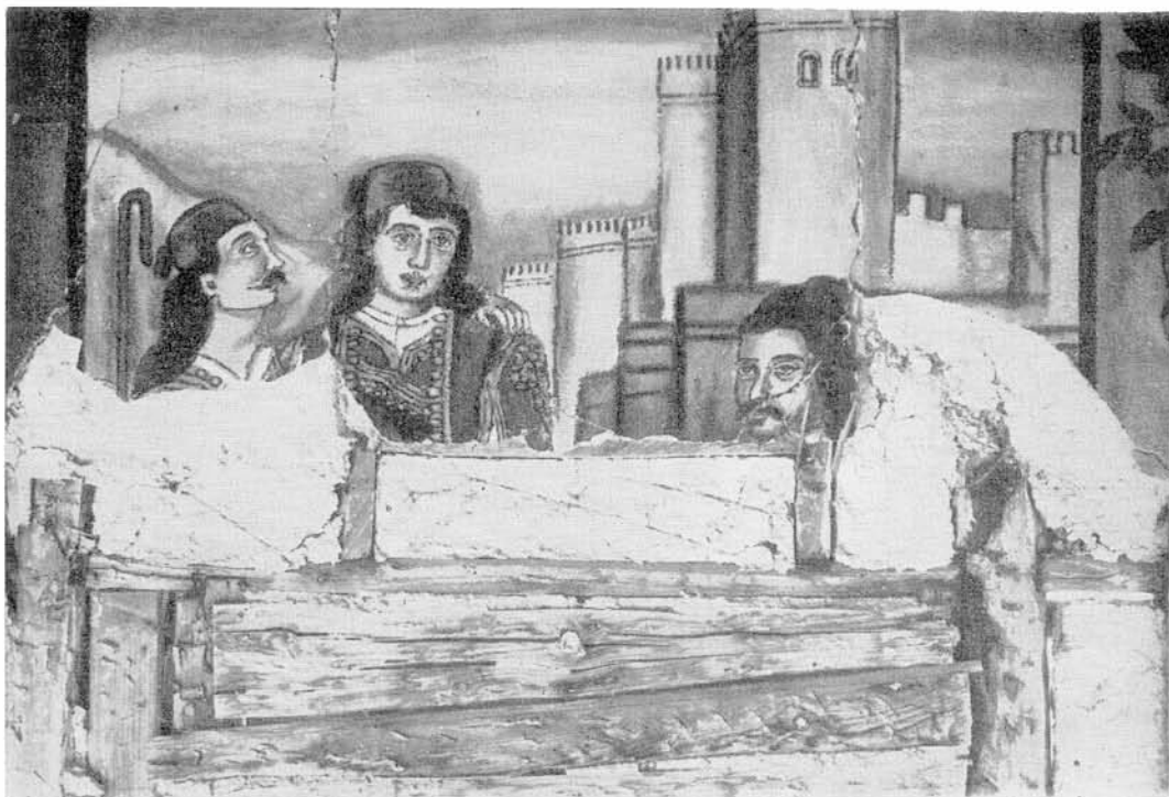
Βόλος, Ἄνακασιά. Οἰκία Κοντοῦ: α - β. Τοιχογραφία Θεοφίλου. Κατάσταση τοιχογραφῶν πρὸ τῶν ἐργασιῶν
