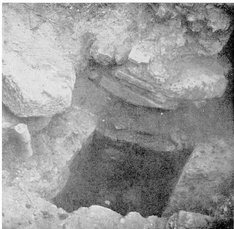
Ἀθήναι: α - β. Ὁ ἀγωγὸς ἀποχετεύσεως τῆς Κλεψύδρας καὶ τὸ φρεάτιον αὐτοῦ
