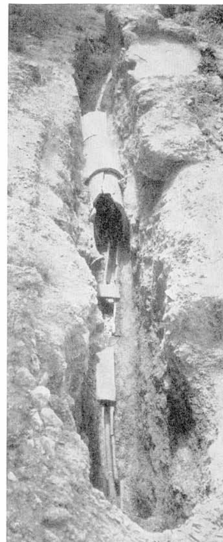
Ἀθήναι: α. Χαλκᾶ ὄπλα ἐκ τάφου νοτίας κλιτύος Ἀκροπόλεως, β. Ἀγωγὸς ἀνατολικῶς τῆς Στοᾶς Εὐμένους
