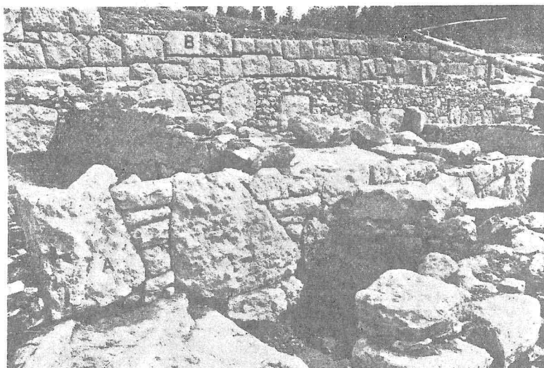
Εἰκ. 30. Β ἀναλημματικὸς τοῖχος βορείας πλευρᾶς ὁδοῦ νοτίου τμήματος πόλεως Ἐλευσίνος. Α τοῖχοι οἰκῆματος νοτίως καὶ χαμηλότερον τῆς παρὰ τὸν ἀναλημματικὸν τοῖχον ὁδοῦ.
