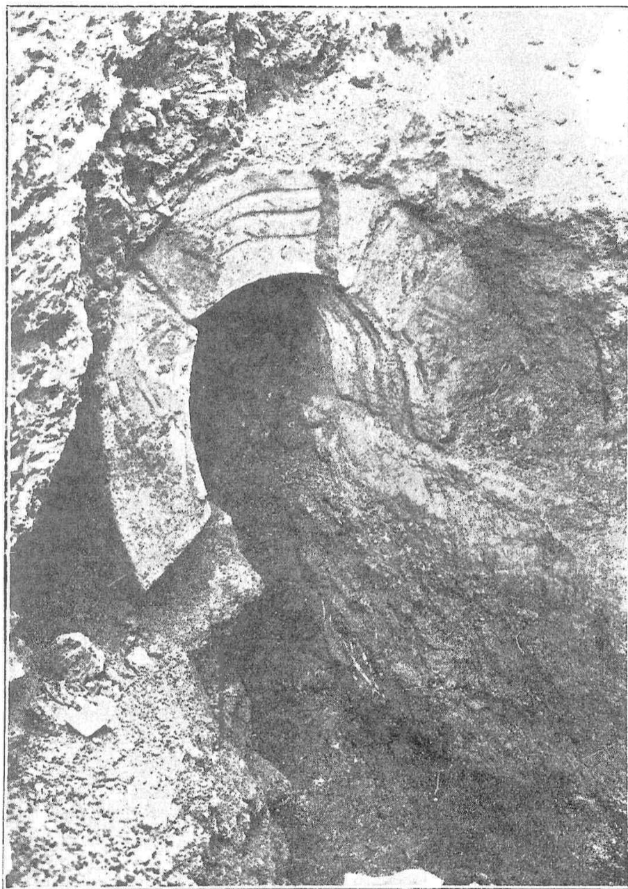
Εἰκ. 6. Θολωτὴ ὑπόνομος παλαιῶν ἀνακτόρων.
