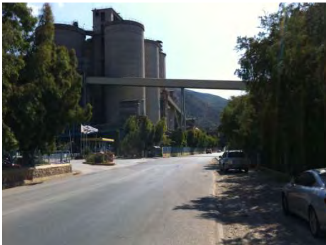
Είσοδος-Εξοδος εργοστασίου ΑΓΕΤ
