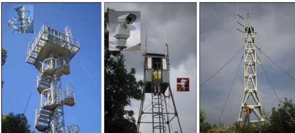
Εικόνα 6.9: Πειραματικοί σταθμοί ελέγχου τοποθετημένοι σε πύργους παρατήρησης πυρκαγιάς στη Κροατία
