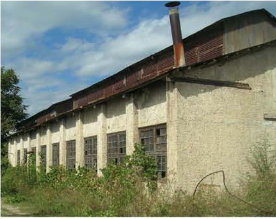
Εικόνα 11. Όψη του μηχανουργείου όπου φαίνονται οι φωταγωγοί_ πηγή: προσωπικό αρχείο 2010
