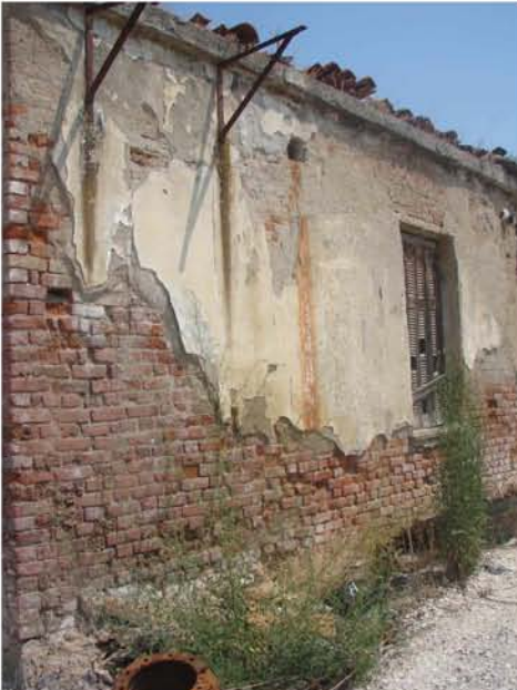
Εικόνα 14. Κτίριο διεύθυνσης _ πηγή: προσωπικό αρχείο 2010
