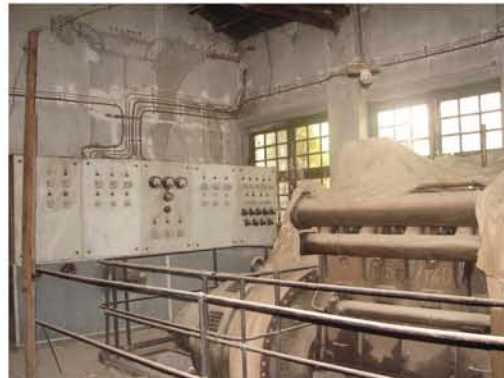
Εικόνα 27. Ηλεκτρογεννήτρια Mann Dieselmotor κατασκευής 1938_ πηγή: προσωπικό αρχείο 2010
