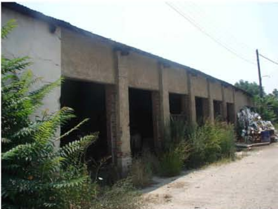
Εικόνα 8. Όψη ανατολικών αποθηκών όπου διακρίνονται οι διαδοχικοί πεσσοί _ πηγή: προσωπικό αρχείο 2010
