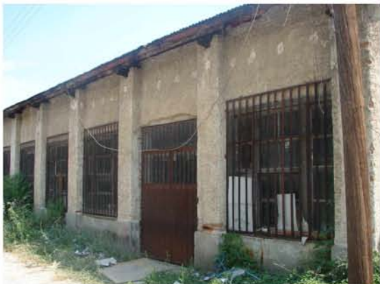
Εικόνα 10. Όψη των ανατολικών αποθηκών_ πηγή: προσωπικό αρχείο 2010
