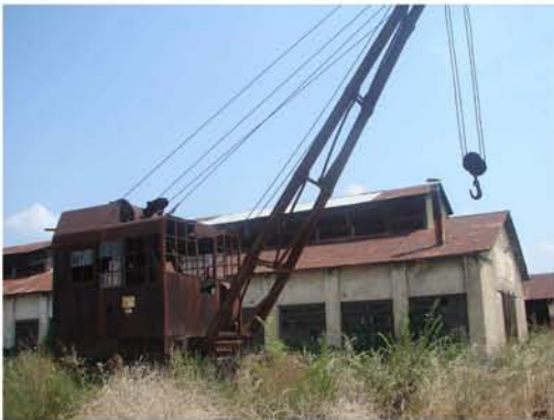
Εικόνα 29. Μηχανουργείο - γερανός Lubecker-Maschinenbau-Gesellschaft _ πηγή: προσωπικό αρχείο 2010
