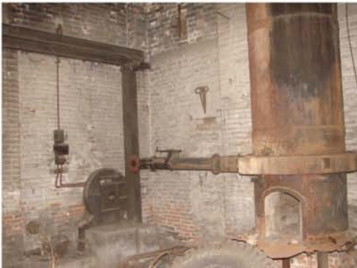
Εικόνα 26. Φούρνος στο χυτήριο_ πηγή: προσωπικό αρχείο 2010
