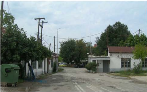
Εικόνα 6. Η κεντρική πύλη του εργοταξίου _ πηγή: προσωπικό αρχείο 2010
