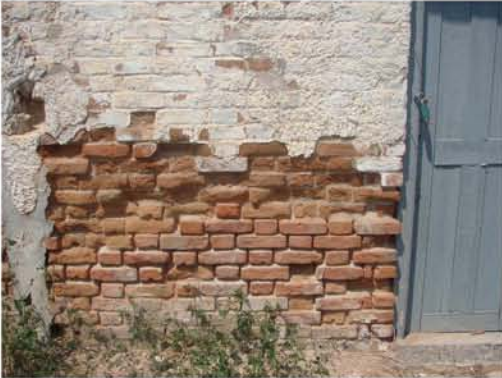
Εικόνα 13. Λεπτομέρεια όψης κτιρίου λουτρών _ πηγή: προσωπικό αρχείο 2010
