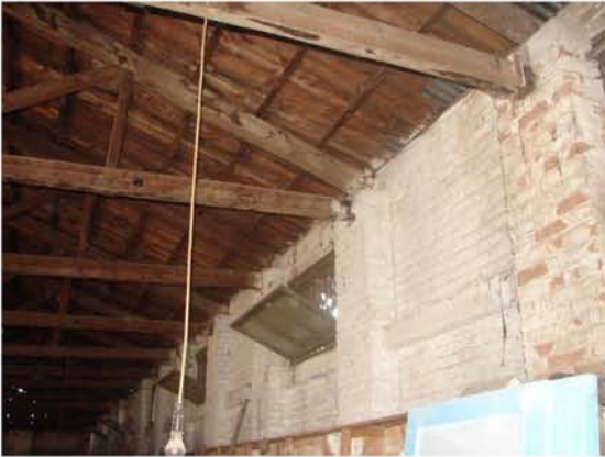
Εικόνα 12. Εσωτερικό ξύλινης στέγης των αποθηκών εισόδου_ πηγή: προσωπικό αρχείο 2010
