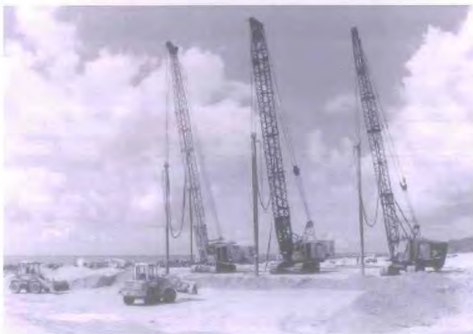
Σχ. 1.8 & 1.9 Δυναμική συμπίκνωση και αντικατάσταση χαλικοπασάλων
