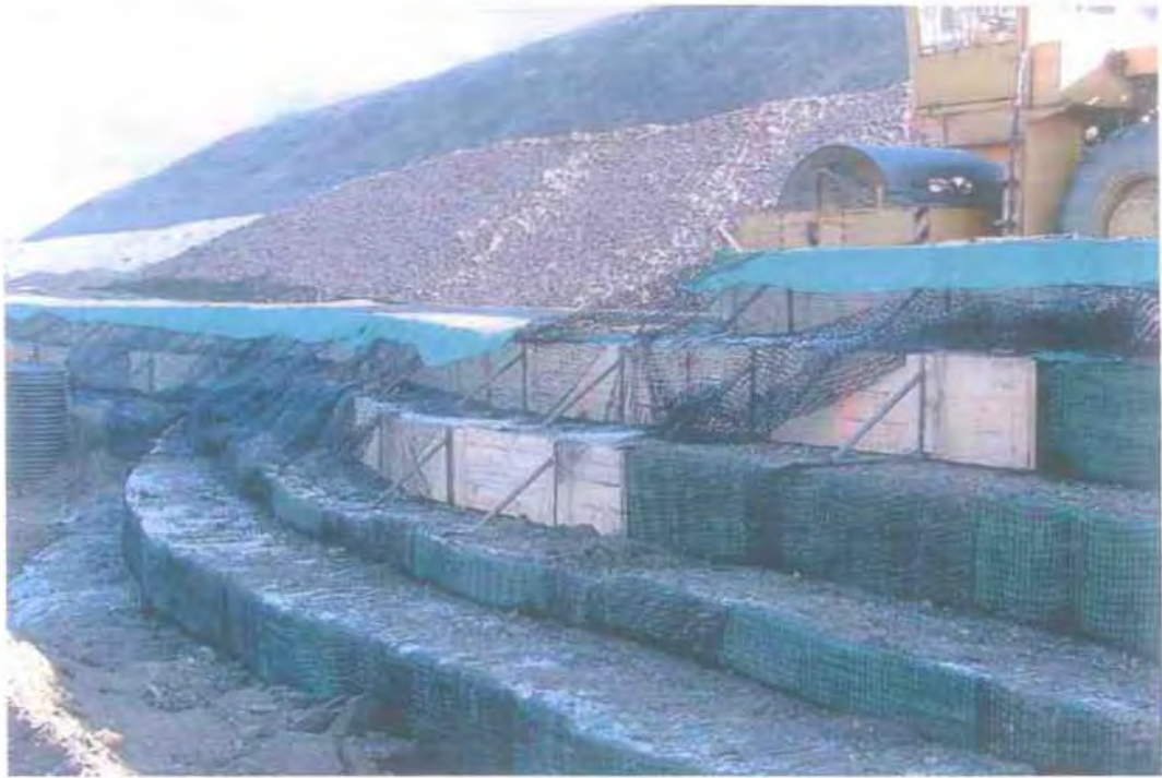
Σχήμα 1.4 Έδαφος οπλισμένο με γεωπλέγματα
