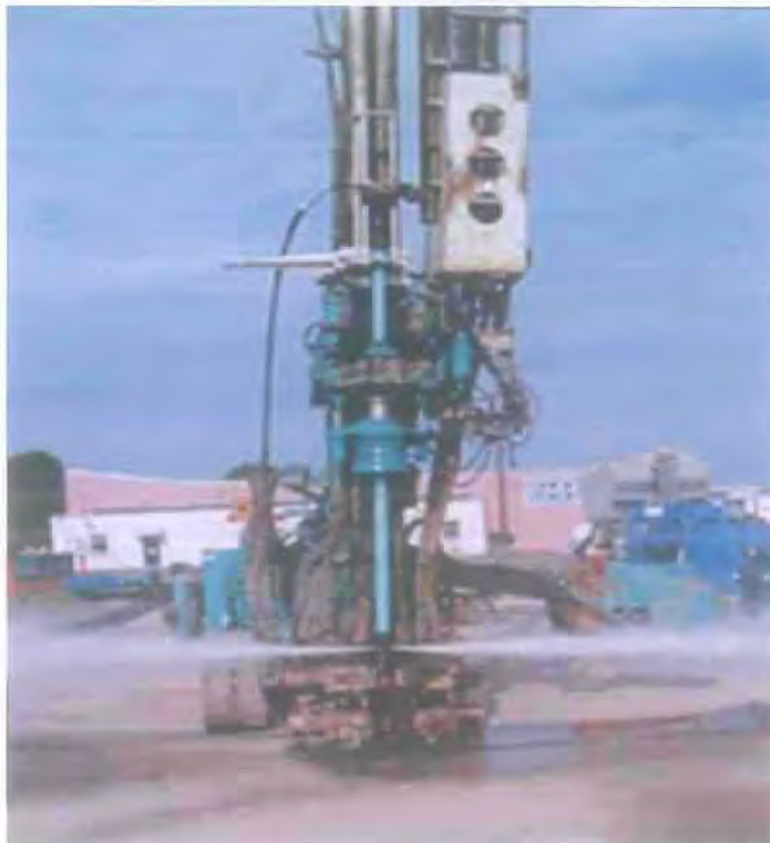
Σχήμα 1.11 Φωτογραφία από την διαδικασία έγχυσης ενέματος τσιμέντου για την δημιουργία τσιμεντοπασσάλων
