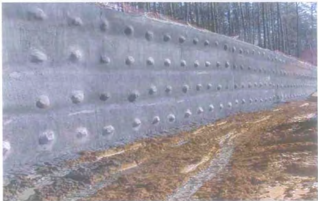
Σχήμα 1.5 Εδαφοϋλώσεις (soil nailing)
