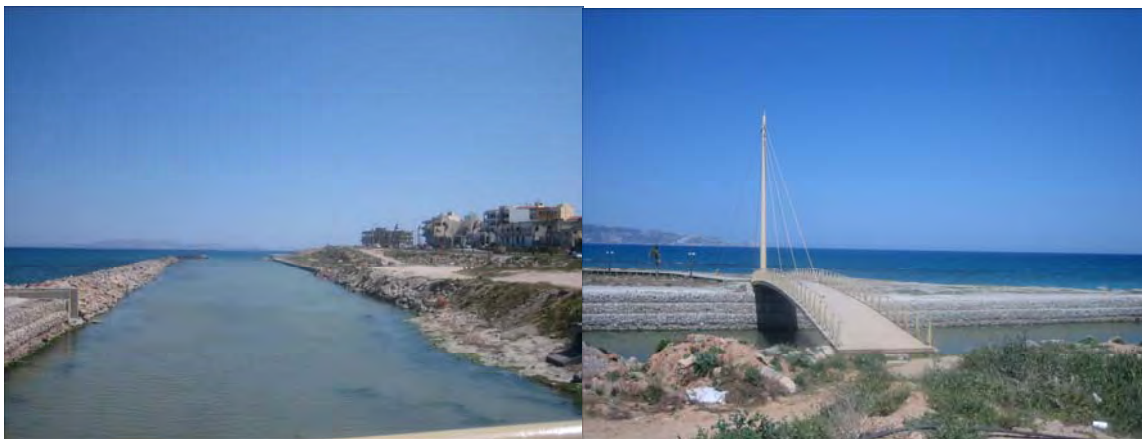
Εικ. 10,11, Φωτογραφίες από την πεζογέφυρα και την διαμορφωμένη κοίτη του ποταμιού
