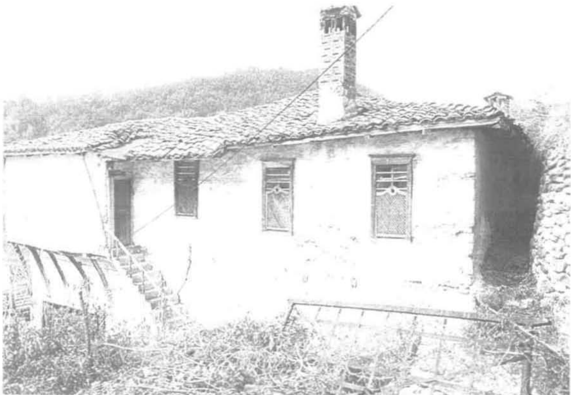
Εικόνα 20: Ανατολική όψη κονακίου στο Εχίνο Ξάνθης. Το σαχνίσι πάνω από την αυλόπορτα έχει αποκτήσει άμεση πρόσβαση με νεότερη σκάλα
