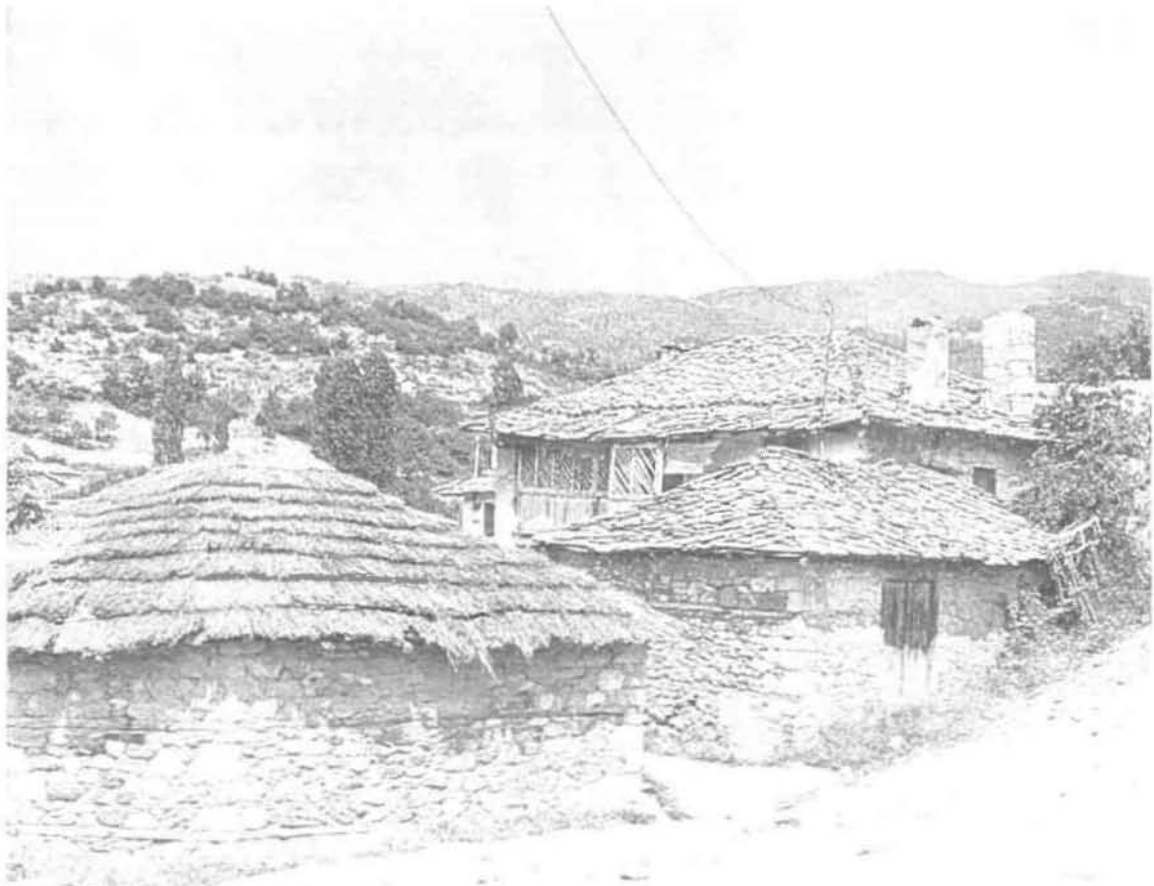
Εικόνα 13: Δρανιά Ροδόπης. Τρεις τεχνικές στεγάσεως μαζί, βούρλα, πλάκες κεραμίδια
