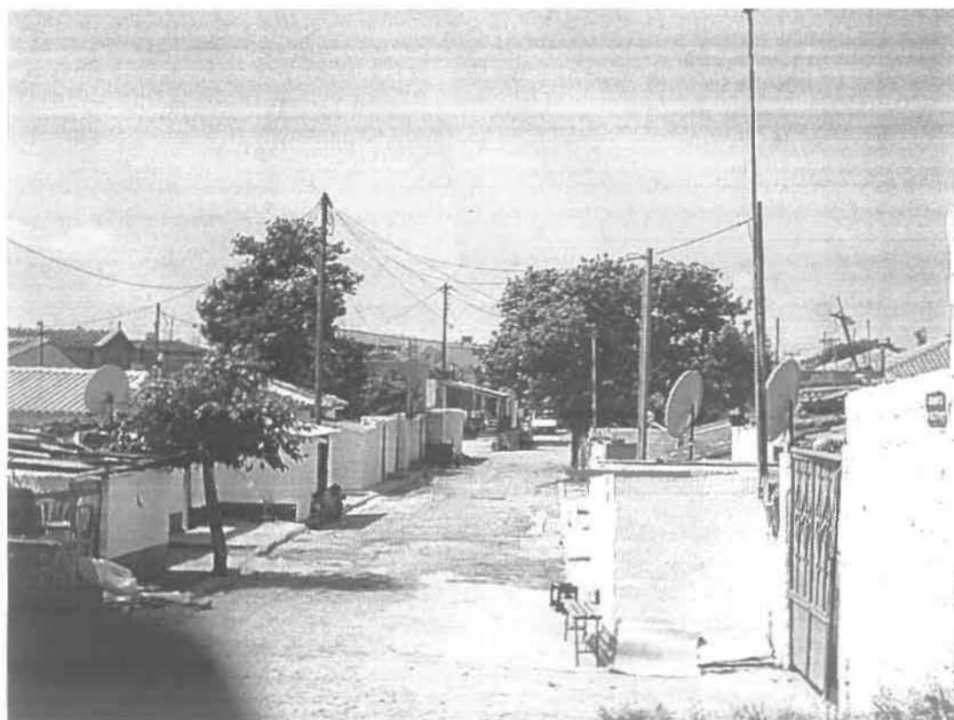
Εικόνα 51: Τσιμεντόδρομος στον Ήφαιστο Ροδόπης
