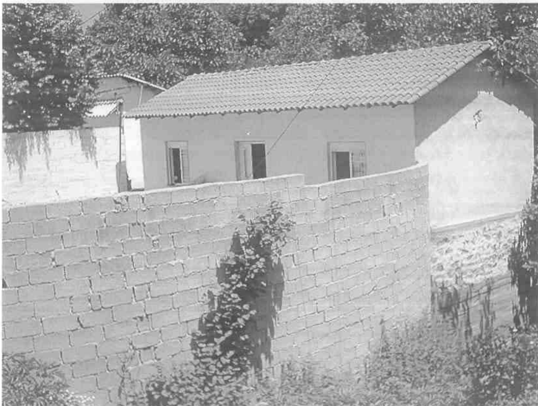
Εικόνα 31: Ανακατασκευασμένο σπίτι στην Οργάνη με πρόσφατη κατασκευή ψηλού αυλόγυρου από τσιμεντόλιθους
