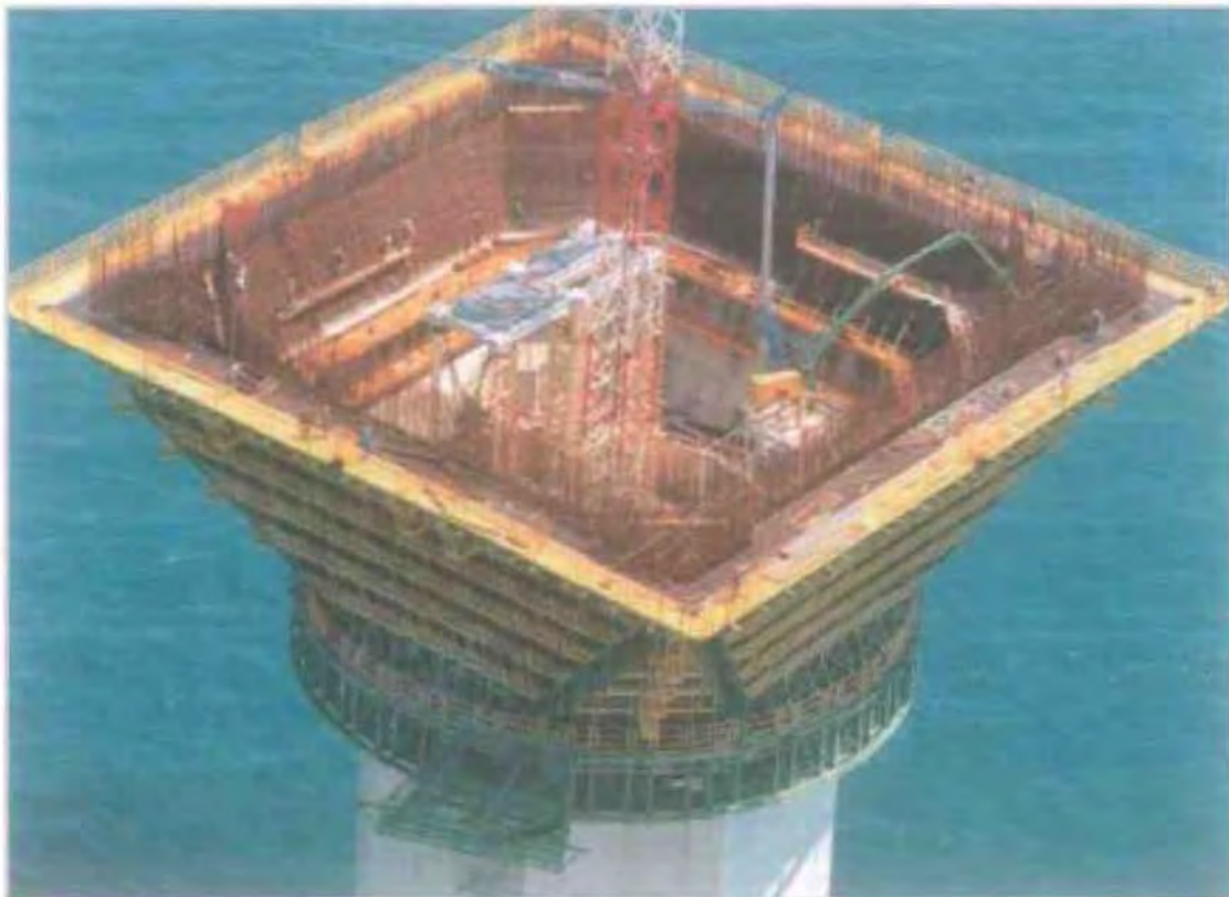
Εικόνα 2.5.3.5. Η κατασκευή της κεφαλής του πυλώνα M4 έχει ολοκληρωθεί
