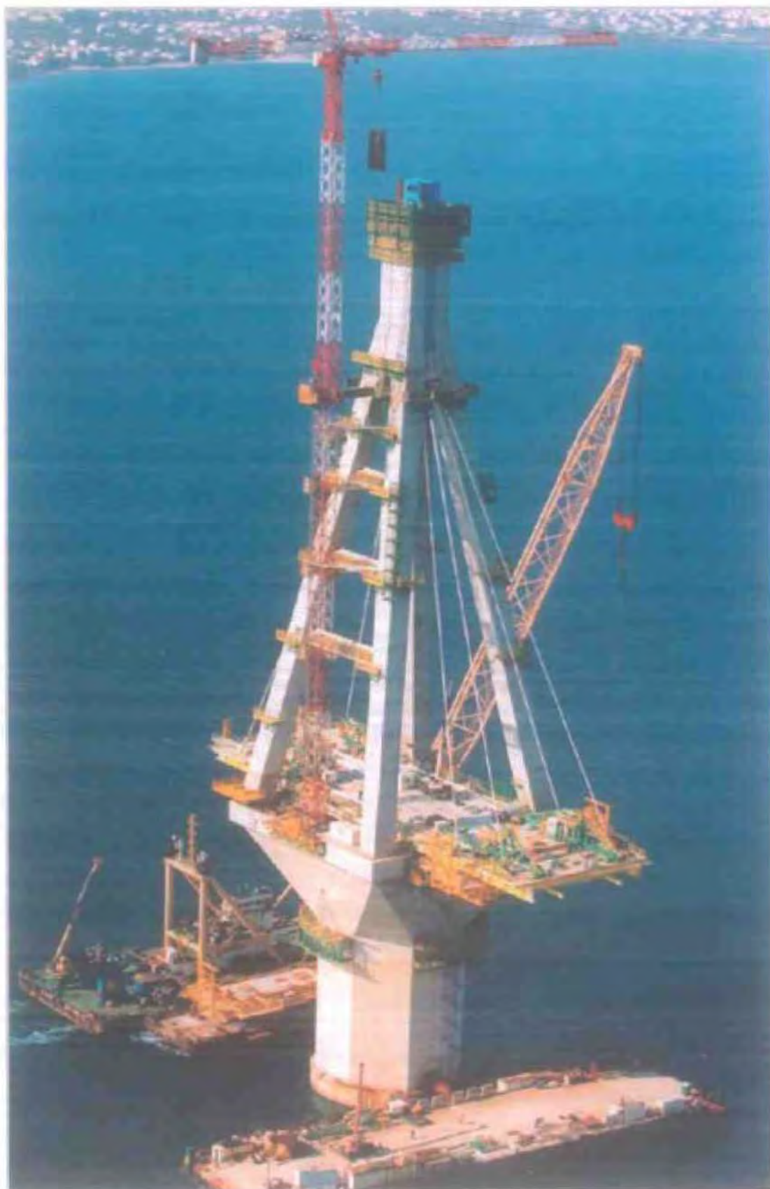
Εικόνα 2.6.2. Ο πυλώνας Μ3 με το αναρτημένο κατάστρωμα (Ιούλιος 2003)
