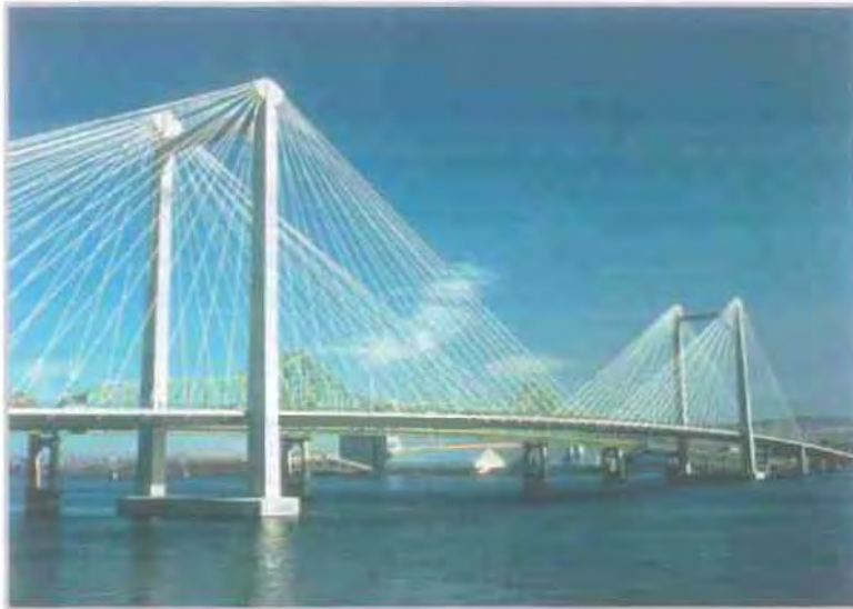
Εικόνα 2.7.1.6. Η γέφυρα Pasco Kennewick (ΗΠΑ)
