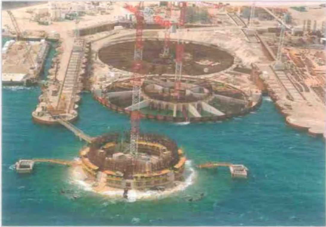
Εικόνα 2.5.5.1. Το πέλαμα του πυλώνα M4 πριν την ρυμούλκηση
