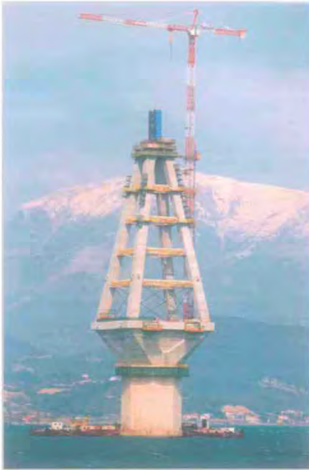
Εικόνα 2.5.3.2. Η πλήρης δομή του πυλώνα Μ3
