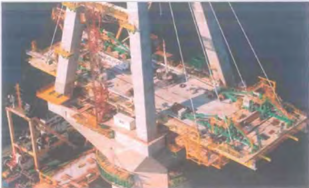
Εικόνα 2.6.1. Τοποθέτηση των πρώτων τμημάτων καταστρώματος (Ιούλιος, 2003)
