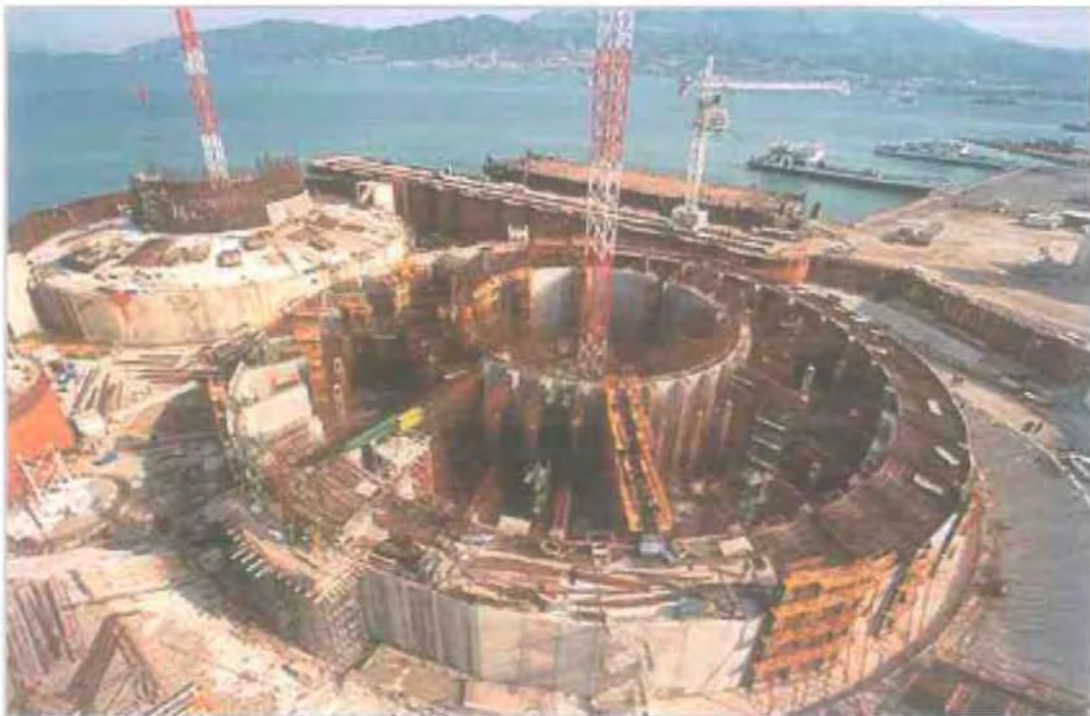
Εικόνα 2.5.5.2. Το πέλαμα του πυλώνα M2 στο ανώτερο επίπεδο της ξηράς δεξαμενής
