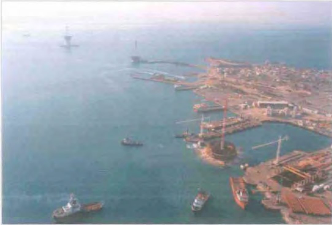
Εικόνα 2.5.5.3. Ρυμούλκηση του πυλώνα Μ1 εκτός ξηράς δεξαμενής
