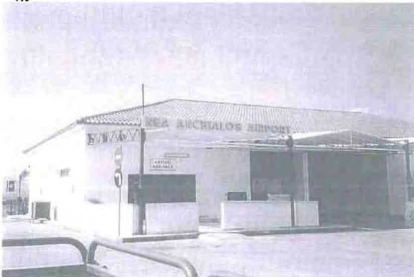
Εικόνα 57: Αποψη του κτιρίου και του αερολιμένα του πολιτικού αεροδρομίου Νέας Αγχιάλου
