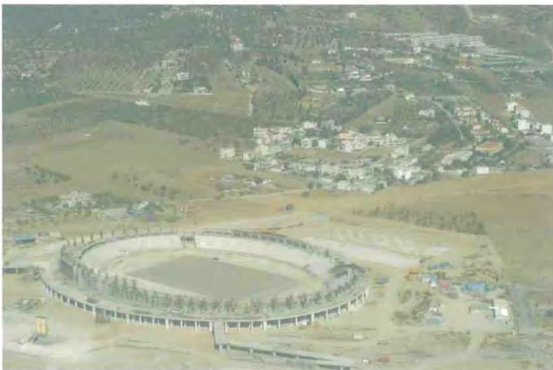
Εικόνα 20: Πανθεσσαλικό Σταδίο Βόλου υπό κατασκευή (άποψη του γηπέδου από τα νοτιο-δυτικά)
