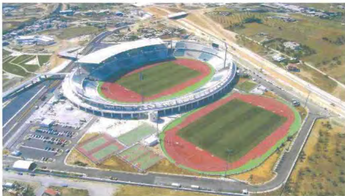
Εικόνα 28: Πανθεσσαλικό Στάδιο Βόλου (άποψη του σταδίου και του βοηθητικού γηπέδου από αεροφωτογραφία)
