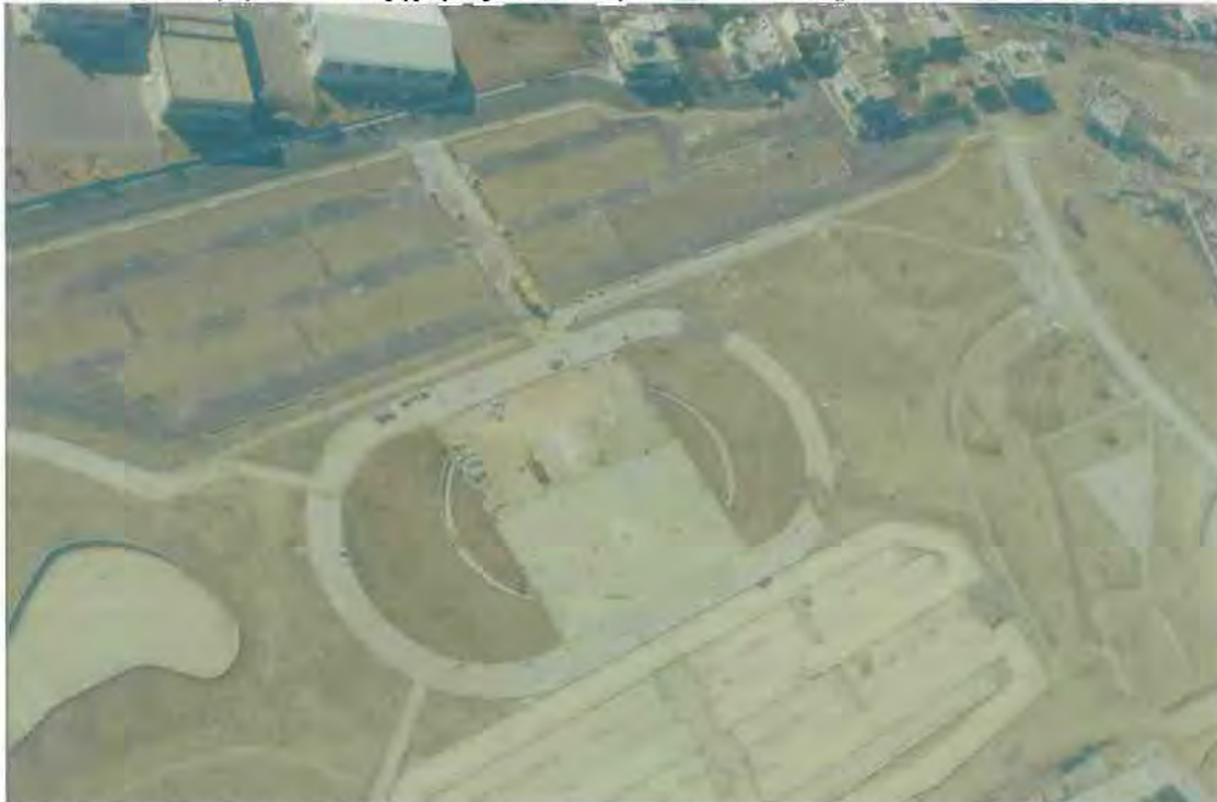
Εικόνα 22: Περιβάλλοντας χώρος ΠΑΚΘ (υπό κατασκευή)
