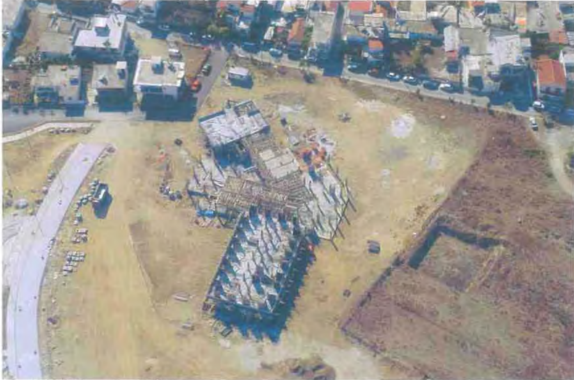
Εικόνα 23: Ξενώνας αθλητών ΠΑΚΘ (υπό κατασκευή)
