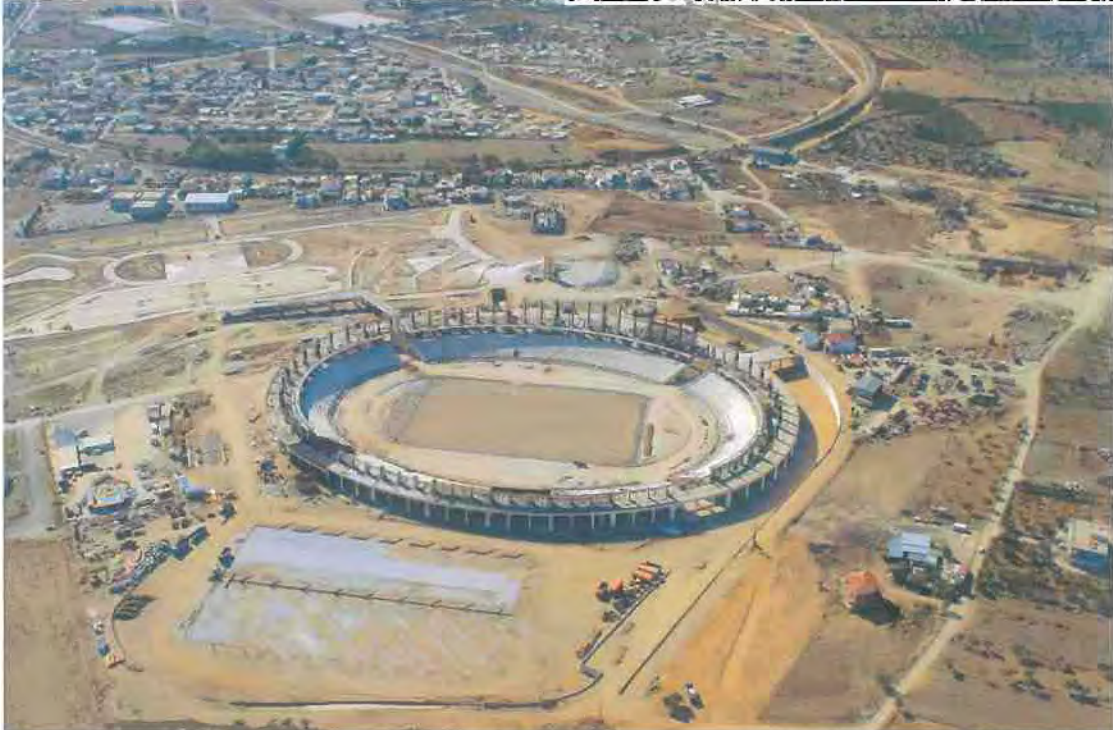
Εικόνα 21: Πανθεσσαλικό Στάδιο Βόλου υπό κατασκευή(άποψη του σταδίου και του βοηθητικού γηπέδου από αεροφωτογραφία)
