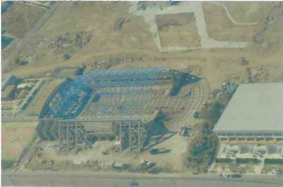
Εικόνα 24: Κολυμβητήριο ΠΑΚΘ (υπό κατασκευή)
