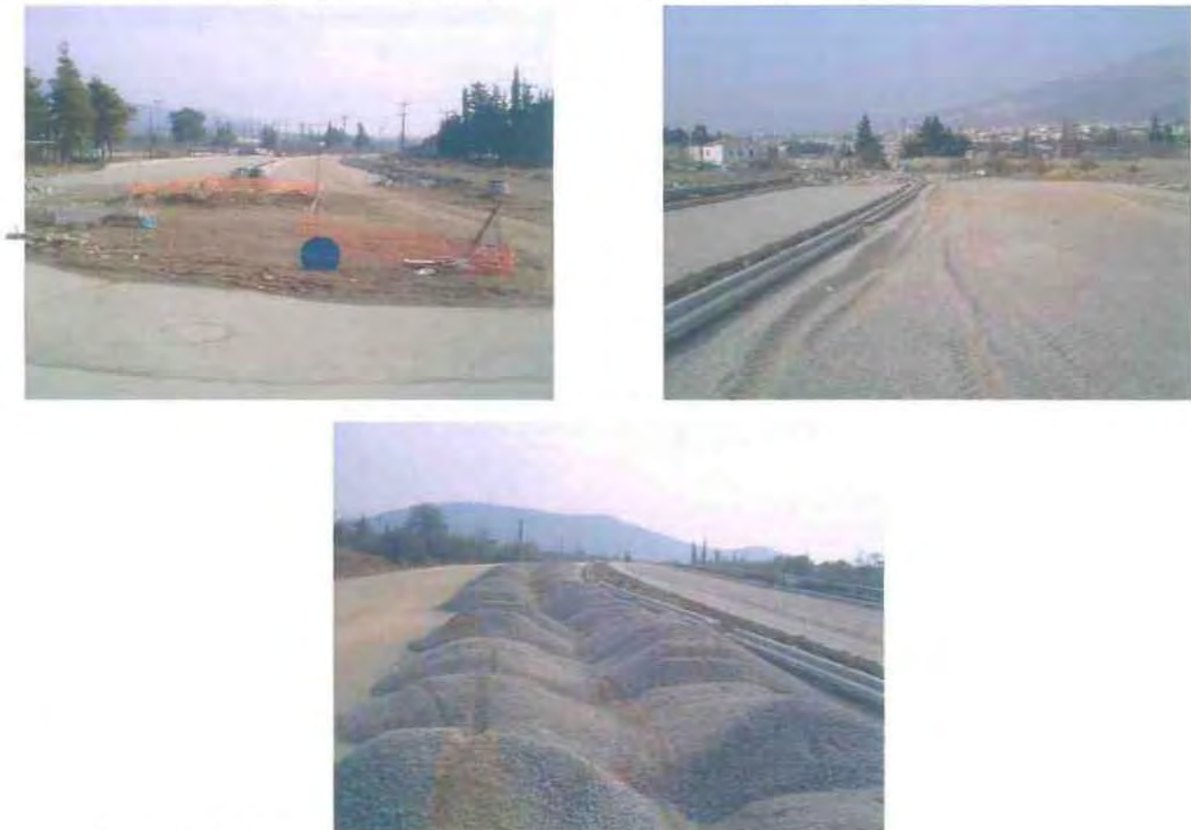
Εικόνα 36: Μερική άποψη από την κατασκευή του περιφερειακού
