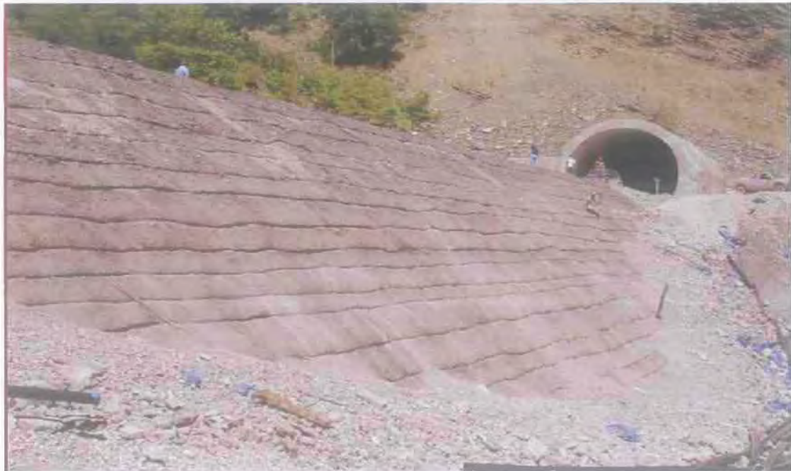
Εικόνα 3.27 Κατασκευή επιχώματος: αναδίπλωση γεωπλεγμάτων για την διαμόρφωση της όψης στην Εθνική οδό Τρικάλων - Άρτας
