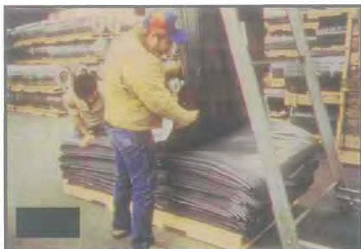
Εικόνα 3.11 Γεωμεμβράνες κατά την τοποθέτησή τους
