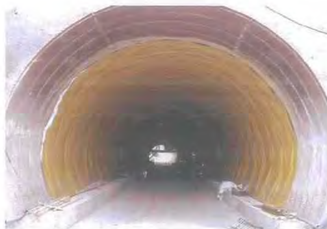
Εικόνα 3.34 Τοποθέτηση γεωμεμβράνης PVC στο εσωτερικό σήραγγας
