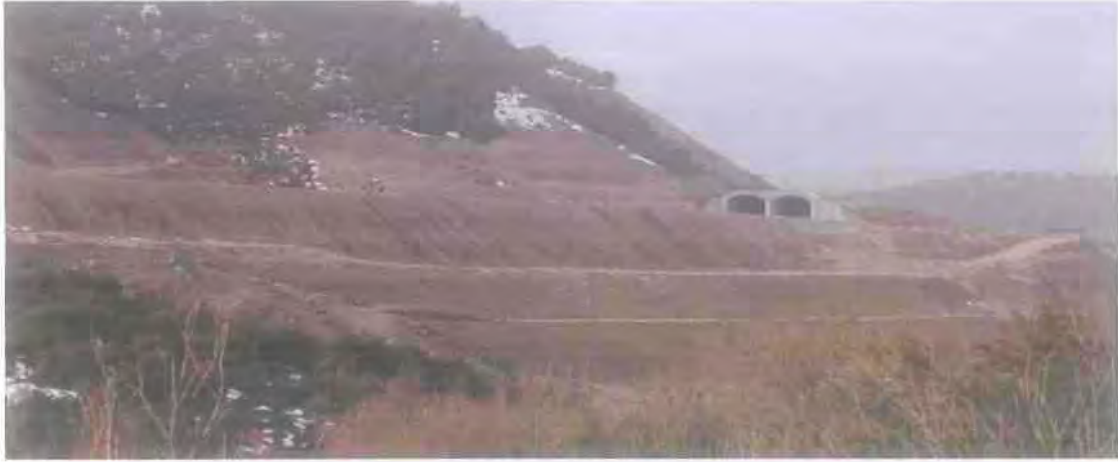
Εικόνα 3.26 Άποψη κατασκευασμένου οπλισμένου επιχώματος στην Εγνατία οδό – περιοχή Μετσόβου
