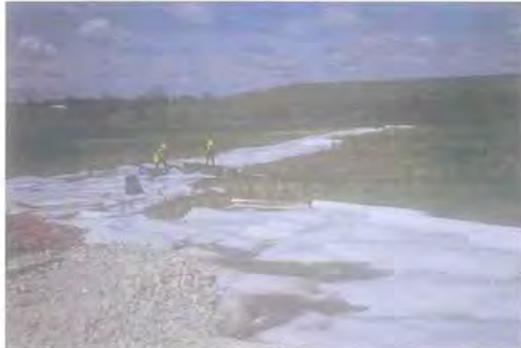
Εικόνα 3.24 Τοποθέτηση γεωπλέγματος κατευθείαν πάνω στην επιφάνεια ασθενούς Εδάφους
