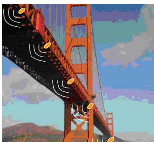
Εικόνα 1.6 : SNs σε γέφυρα για έλεγχο της στατικότητας αυτής
