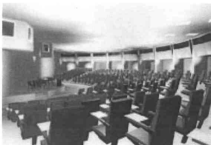
ΦΩΤΟΓΡΑΦΙΑ 16: ΑΠΟΨΗ ΣΥΝΕΔΡΙΑΚΟΥ ΚΕΝΤΡΟΥ ΠΟΥ ΚΑΤΑΣΚΕΥΑΖΕΤΑΙ ΣΤΗΝ ΚΕΡΚΥΡΑ
