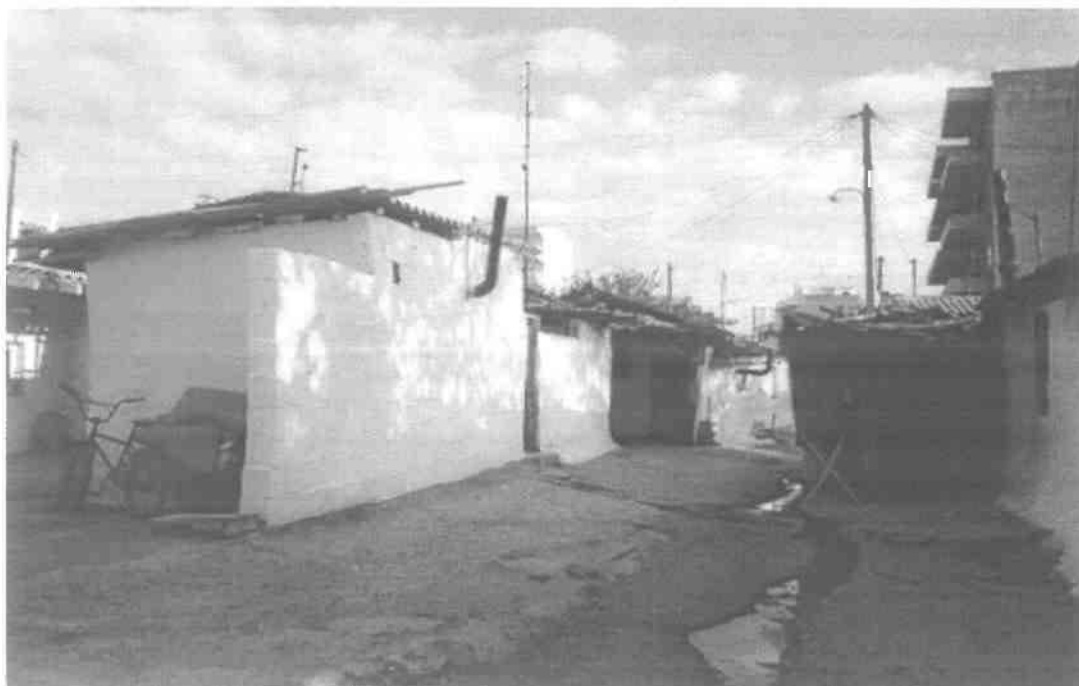
Φωτογραφία 5: Κατοικίες Μουσουλμάνων Ρομ με ανύπαρκτες υποδομές
