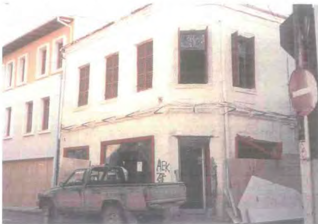
εικ.6.2: Ανεκμετάλλευτο κτίσμα στις οδούς Π. Τσαλδάρη- Αριστοτέλους πριν την επέμβαση. Σήμερα φιλοξενεί κατάστημα ένδυσης
