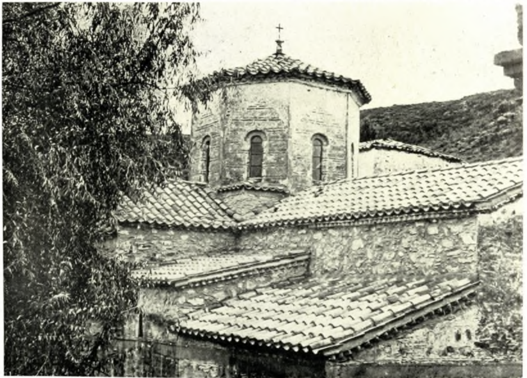
Λακωνία. Γ. Μονή Ἁγίων Τεσσαράκοντα ἐν Λακεδαίμονι: α - β. Ἡ στέγη τοῦ ναοῦ κατὰ καὶ μετὰ τὰς στερεωτικὰς ἐργασίας
