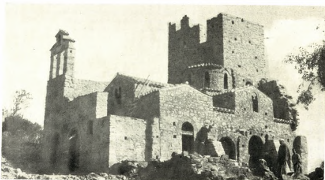
Λακωνία. Ναός της Χρυσοφιτίσης: α - β. 'Η Α. πλευρά τοῦ πύργου καὶ ὁ ναὸς μετὰ τὴν στέρεωσιν
