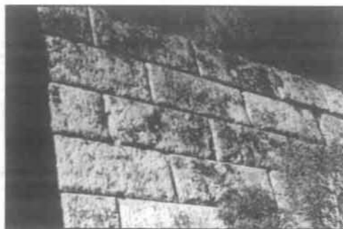
Τμήμα του οχυρωματικού περιβόλου της ακρόπολης. (φωτ. 4)
