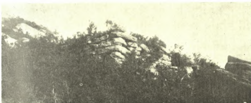
Εἰκ. 1. Ἀνατολικὸς τετράπλευρος πύργος τῆς Οἰσύμης.
