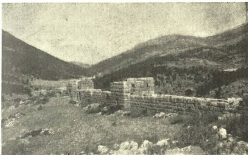
Εἰκ. 1. Πύργοι καὶ μεταπύργια τῆς βορείου πλευρᾶς, ὁρώμενα ἐκ τοῦ ἐσωτερικοῦ τοῦ φρουρίου.
