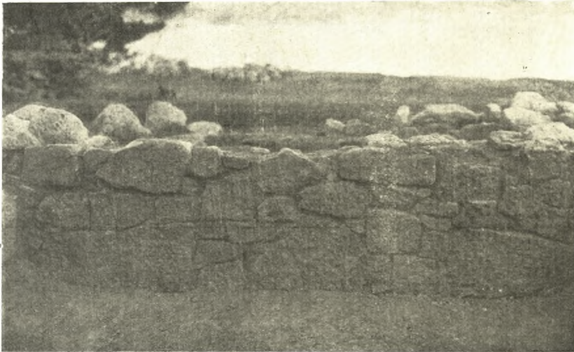
Εἰκ. 9. Ἡ ἐσωτερικὴ ὄψις τμήματος τῆς ἀνατολικῆς πλευρᾶς τοῦ δωματίου Δ.
