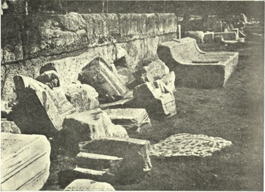
Εἰκ. 12. Ἀρχιτεκτονικά μέλη τοῦ ναοῦ τοῦ Ὀλυμπίου Διὸς χρησιμοποιηθέντα ὡς οἰκοδομικὸν ὑλικὸν διὰ τὴν κατασκευὴν τῶν τοίχων τῆς βασιλικῆς.
