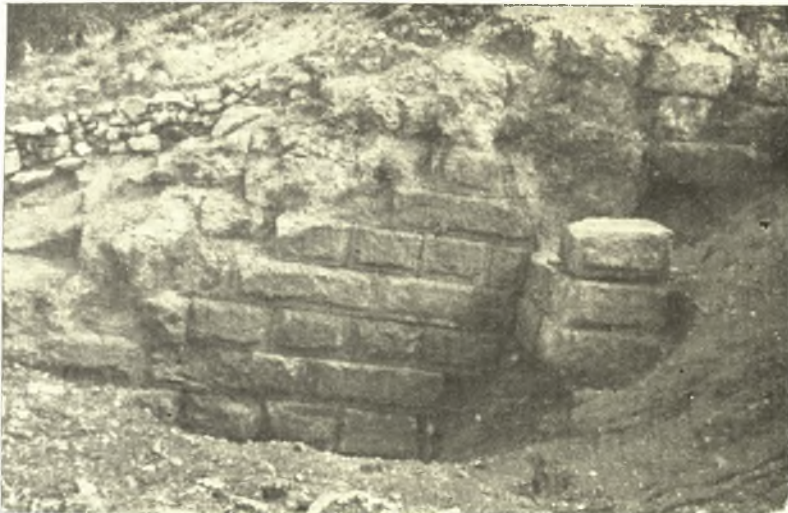
Εἰκ. 4. Δυτικὴ πλευρὰ τοῦ ἀναλήμματος.
